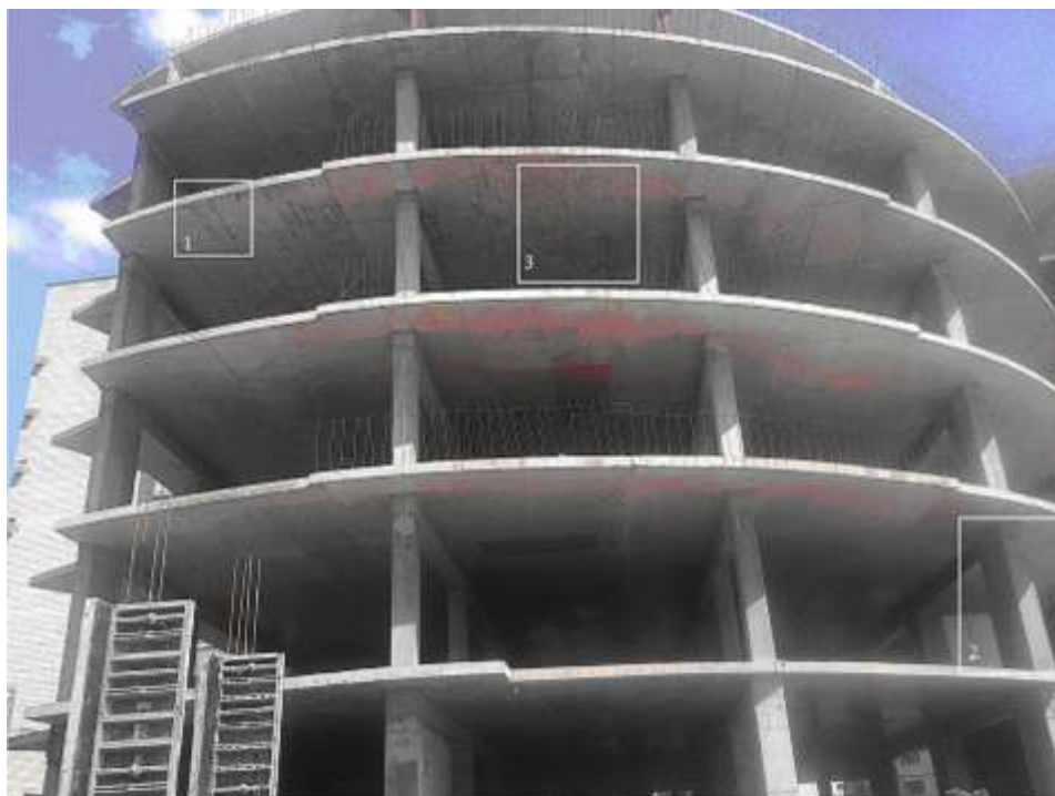
Рис. 6. Існуючий стан будівлі на 21.06.14 р.
