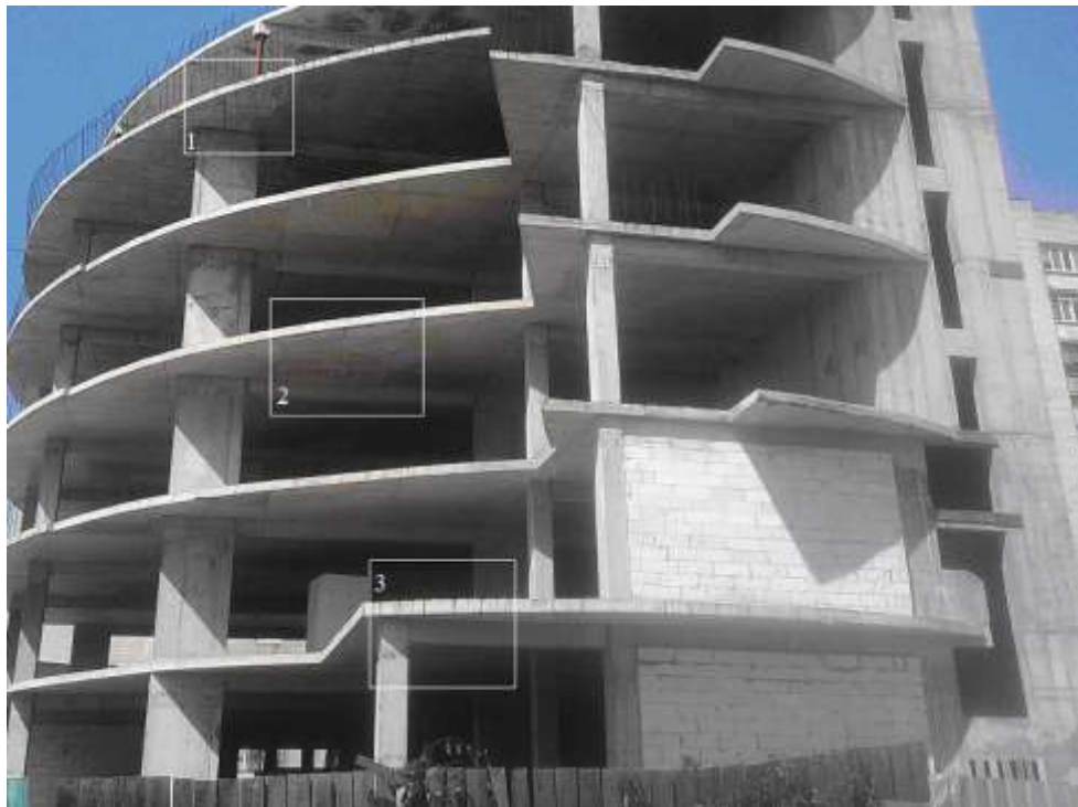
Рис. 3. Існуючий стан будівлі на 21.06.14 р.
