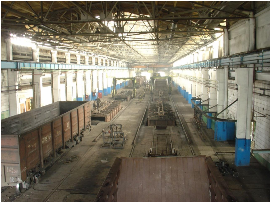
Рис. 1.4. Загальний вигляд вагоноскладальної дільниці депо з ремонту вантажних вагонів
