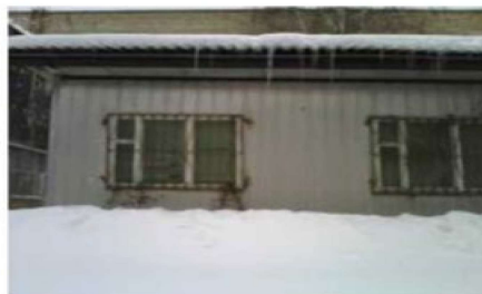
Рис.2. Здание сборное из «сендвич» панелей
