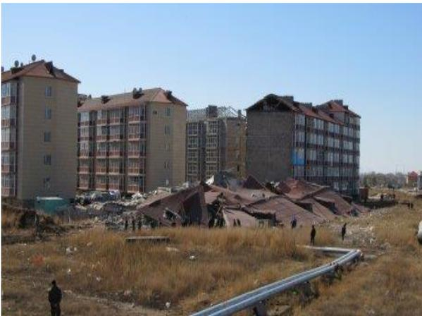
Рис. 10. Обрушение части дома №7 жилого комплекса «Бесоба» [10]
