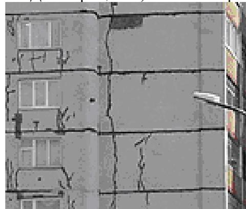
Рис. 4. Увеличенный фрагмент левой секции с трещинами
