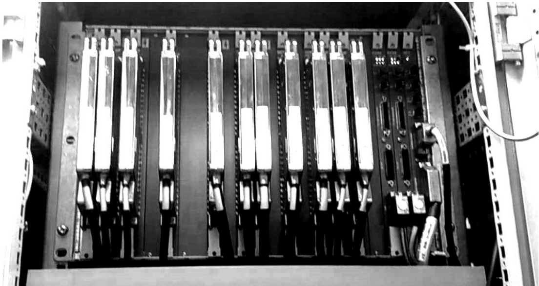
Рисунок 2.4 – Сабрек з ОК та платами концентратора
