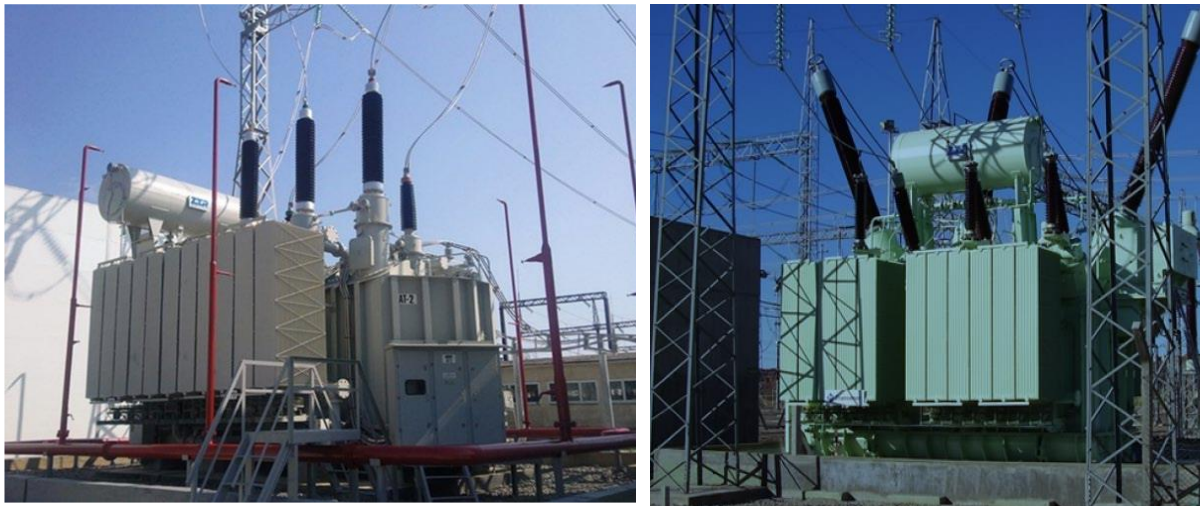
Рисунок 2 – Фазоповоротні (фазозрушуючі) трансформатори
