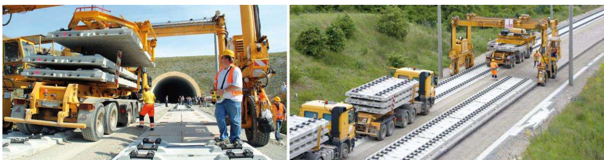
Рис.1 - Укладання плит на ділянці Єдиного транспортного проекту Німеччини
