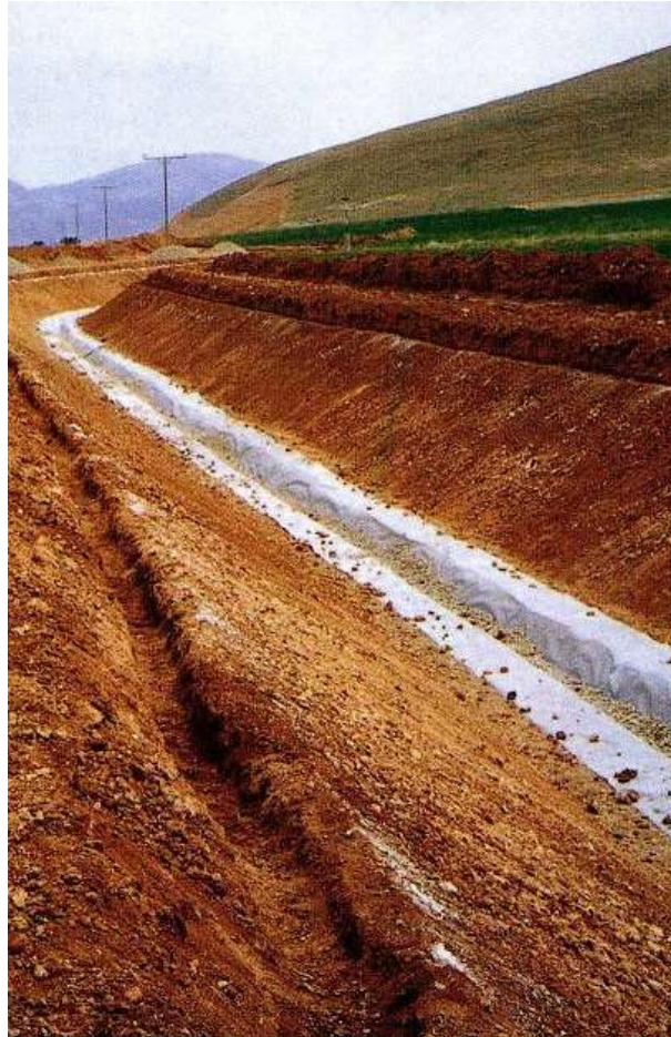
Рис. 6.31. Улаштування дренажів із застосуванням фільтрувального геотекстилю
