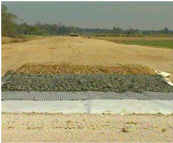
Рис. 6.27. Улаштування підсиленої георешітками та фільтрувальним геотекстилем основного майданчика земляного полотна під час будівництва Угорсько-Словенської залізниці (2000-ні рр.)
