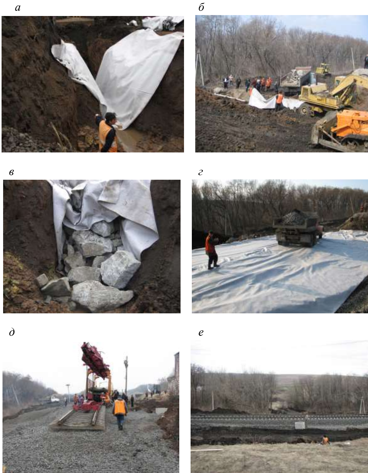
Рис. 5.28. Улаштування дренажних пристроїв під час ліквідації наслідків зсуву біля з. п. Кривошіївка ділянки Куп'янськ – Сватове Південної залізниці, березень 2006 р. (продовження): a – укладання у проріз геотекстилю; б, в – заповнення прорізу дренаючим матеріалом (бутовим каменем); г – підсилення основного майданчика геотекстилем; д – укладання рейко-шпальної решітки та баластування колії; е – відновлена ділянка колії зі смотровими колодзями дренажної системи
