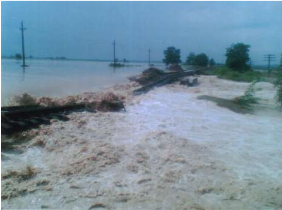
Рис. 3.43. Пошкодження земляного полотна під час повені
