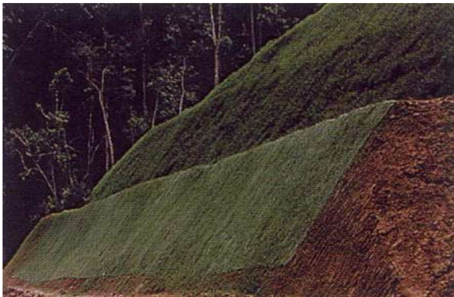
Рис. 6.29. Улаштування земляного полтна та інших земляних споруд геотекстильними матеріалами торговельної марки Polyfelt
