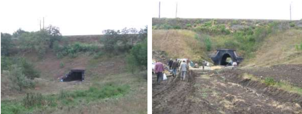
Рис. 5.1. Контрбанкет: a – схема; б – контрбанкети високого насипу на 365 км ділянці Основа – Букине Південної залізниці; i – ухил основи насипу
