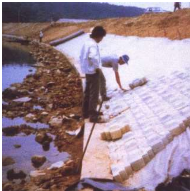
Рис. 5.5. Укріплення укосів мощенням, у т. ч. з прокладанням геотекстилю ( б )
