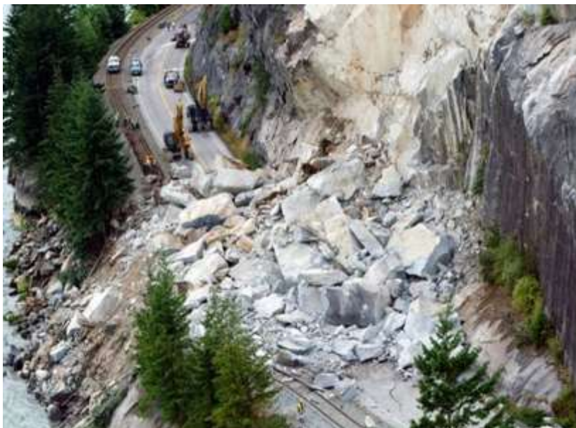
Рис. 3.17. Обвали: а – схема обвалу; б – наслідки обвалу; 1 – траєкторія падіння скельних уламків; 2 – відкладення скельних уламків
