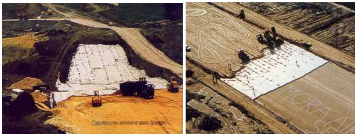
Рис. 6.26. Укладання геотекстилю в основу автомобільних доріг під час будівництва
