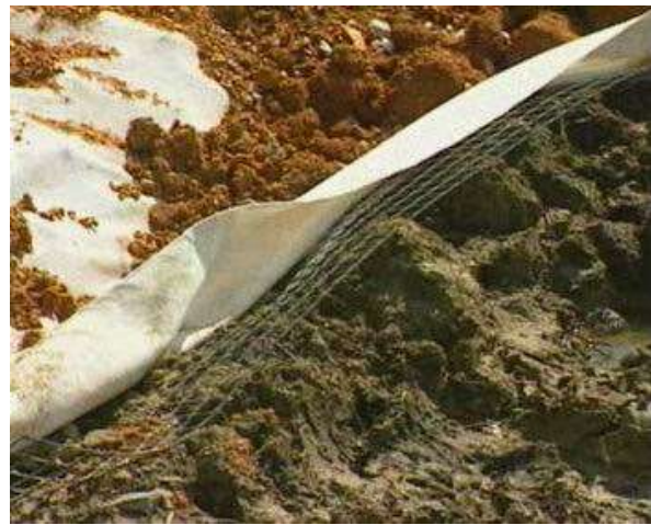
Рис. 6.27. Улаштування підсиленої георешітками та фільтрувальним геотекстилем основного майданчика земляного полотна під час будівництва Угорсько-Словенської залізниці (2000-ні рр.)
