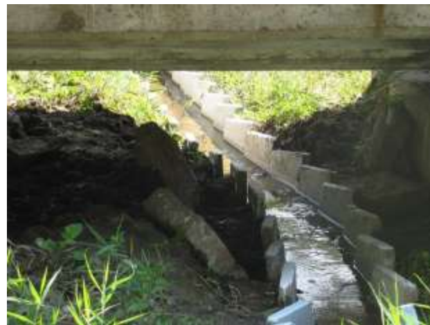
Рис. 5.26. Система поверхневих водовідводів і дренажних пристроїв: a – схема; б – телескопічні водовідвідні лотки (зсувонебезпечний косогір біля ст. Полтава); 1 – вісь колії після зсуву; 2 – первісне положення осі колії; 3 – денна поверхня зсуву; 4 – зрізана і спланована поверхня зсуву; 5 – укіс первісний; б – основна нагірна огорожувальна канава; 7 – поверхня зсуву; 8 – канава, кювет, лоток для відведення вод за межі зсуву; 9 – магістральна канава для відведення вод; 10 – тіло зсуву; 11 – укріплення укосу контрбанкета; 12 – контрбанкет
