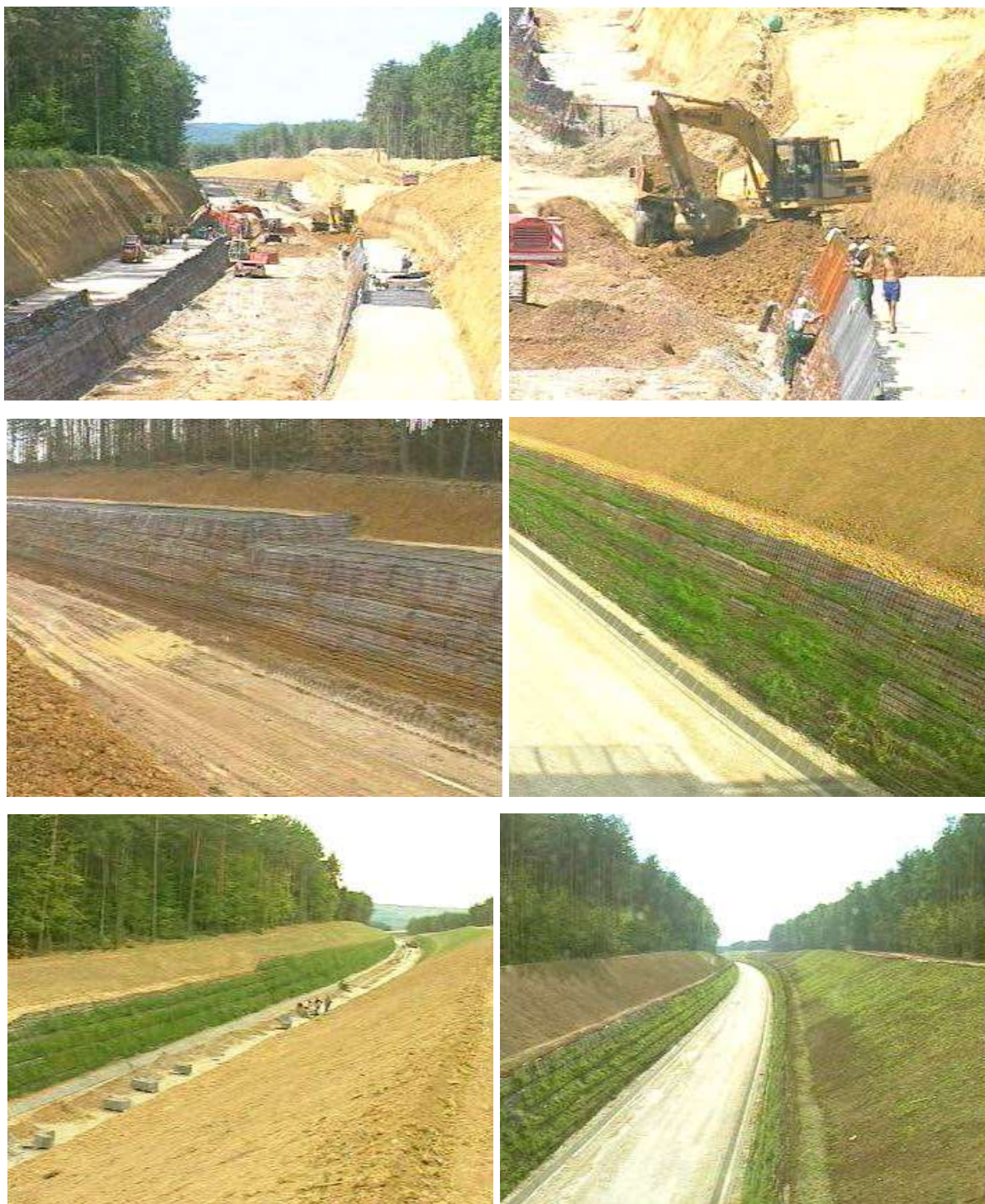
Рис. 6.30. Улаштування підсилених фільтрувальним геотектилем укосів земляного полотна під час будівництва Угорсько-Словенської залізниці (2000-ні рр.)
