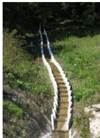
Рис. 5.26. Система поверхневих водовідводів і дренажних пристроїв: a – схема; б – телескопічні водовідвідні лотки (зсувонебезпечний косогір біля ст. Полтава); 1 – вісь колії після зсуву; 2 – первісне положення осі колії; 3 – денна поверхня зсуву; 4 – зрізана і спланована поверхня зсуву; 5 – укіс первісний; б – основна нагірна огорожувальна канава; 7 – поверхня зсуву; 8 – канава, кювет, лоток для відведення вод за межі зсуву; 9 – магістральна канава для відведення вод; 10 – тіло зсуву; 11 – укріплення укосу контрбанкета; 12 – контрбанкет
