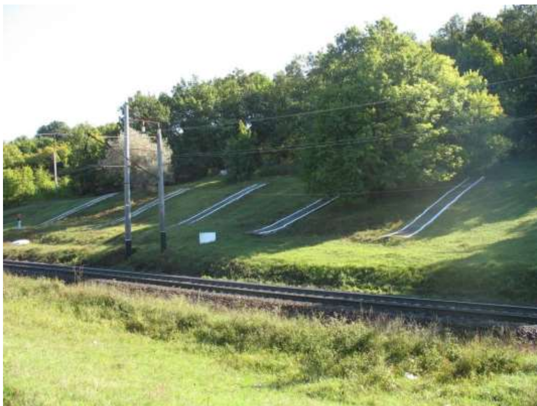
Рис. 5.30. Укріплення зсувних схилів і укосів: а, б, в – буронабивними і забивними палями; г – стовпами; д – стовпи (підземні контрфорси) із кам'яної кладки у зсувонебезпечному косогорі біля ст. Полтава
