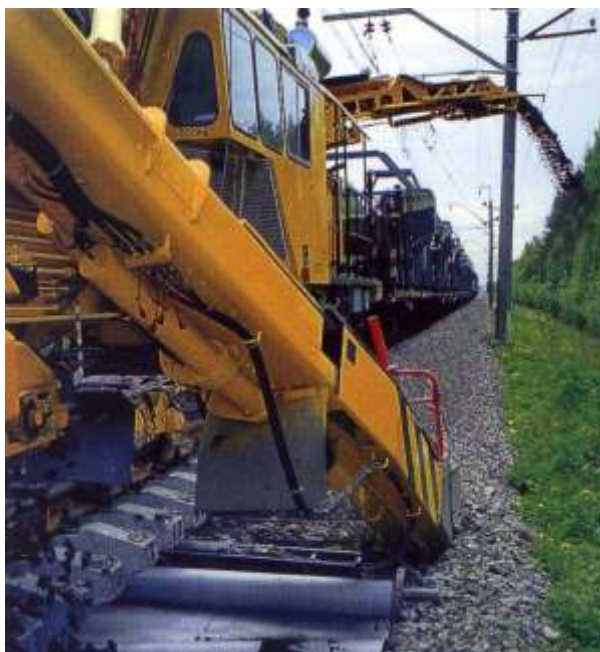
Рис. 6.25. Укладання геотекстилю за допомогою колійних машин під час планово-попереджувальних ремонтів колії
