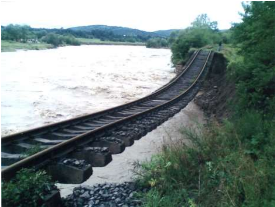
Рис. 3.38. Підмив основи земляного полотна водними потоками: a – схема підмиву; б – руйнування земляного полотна внаслідок підмиву; 1 – місце підмиву; 2 – насип; 3 – основа насипу; 4 – підмитий укіс
