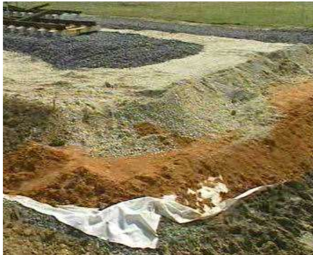
Рис. 6.24. Улаштування підсиленого фільтрувальним геотектилем основного майданчика земляного полотна під час будівництва Угорсько-Словенської залізниці (2000-ні рр.)
