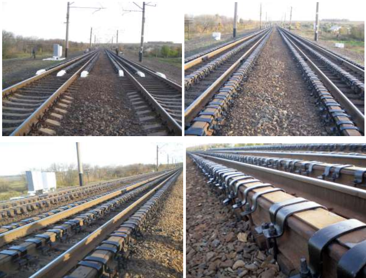
Рис. 6.34. Підсилення рейкової колії рейковими пакетами
