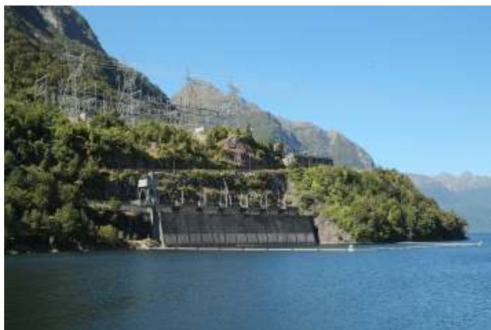
Рис. 2.51. Водозабір електростанції на озері Манапурі
