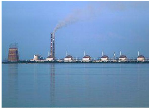
Die thermische Leistung von "Saporischschja" beträgt sogar knapp 20 Gigawatt. Das benötigte Kühlwasser wird dem Fluss Dnepr entnommen, an dessen Ufer die Kraftwerksanlage gebaut wurde. Der Fluss wurde an dieser Stelle extra verbreitert, damit er besser die großen Wärmemengen aufnehmen und abführen kann. Die Leichtwasserreaktoren haben eine elektrische Gesamtleistung von 5.700 MW netto und bilden somit zusammengerechnet die leistungsstärkste Kernkraftwerksanlage Europas.
