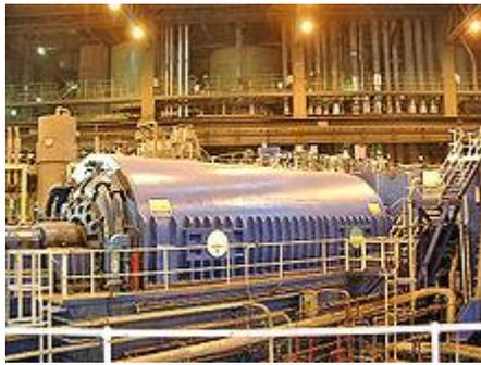
Die Kombination des Turbogenerators und der Turbine wird als Turbosatz bezeichnet.
