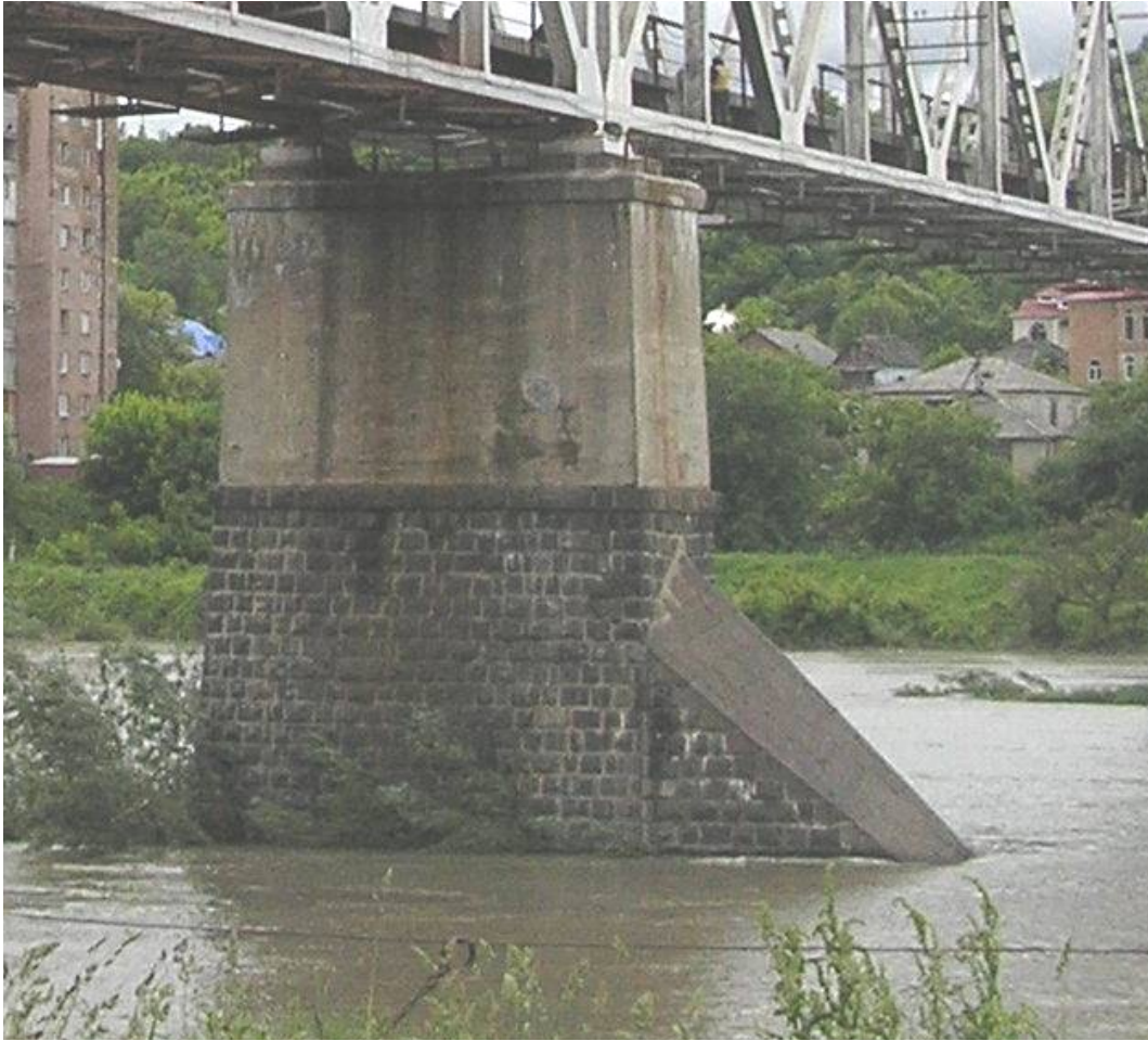
Рис. 77. Проміжна опора з льодорізом
