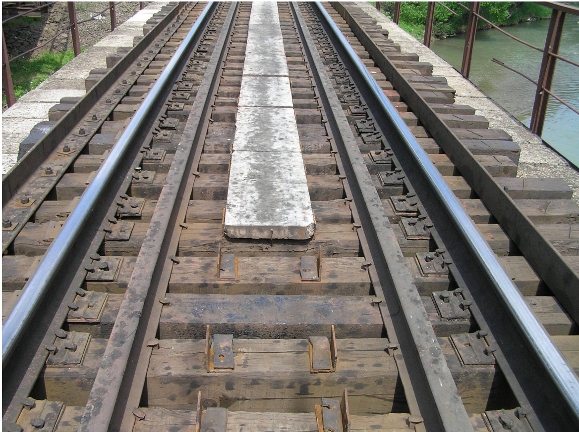
Рис. 103. Експлуатоване мостове полотно з контруктниками і контррейками
