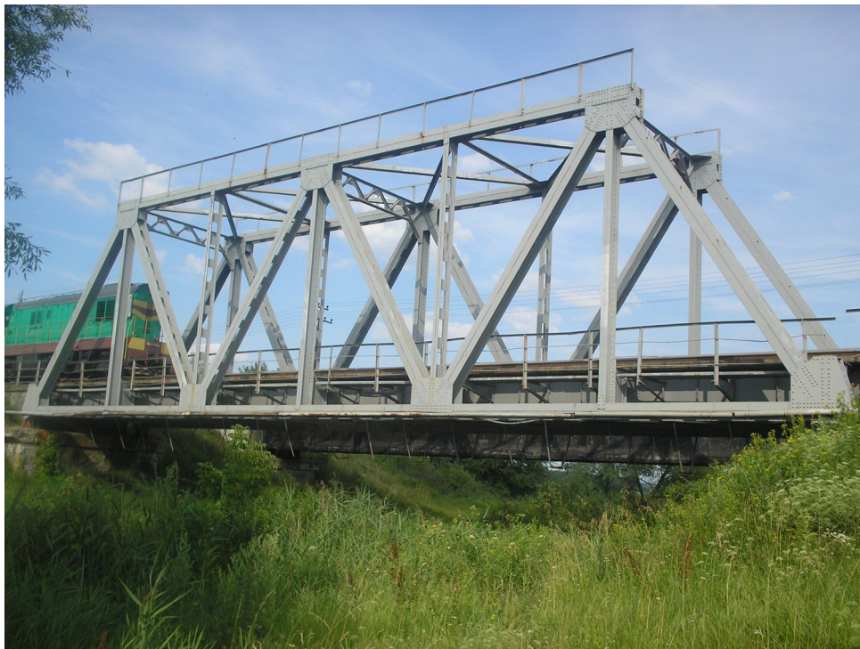
Рис. 62. Металева наскрізна ферма з паралельними поясами
