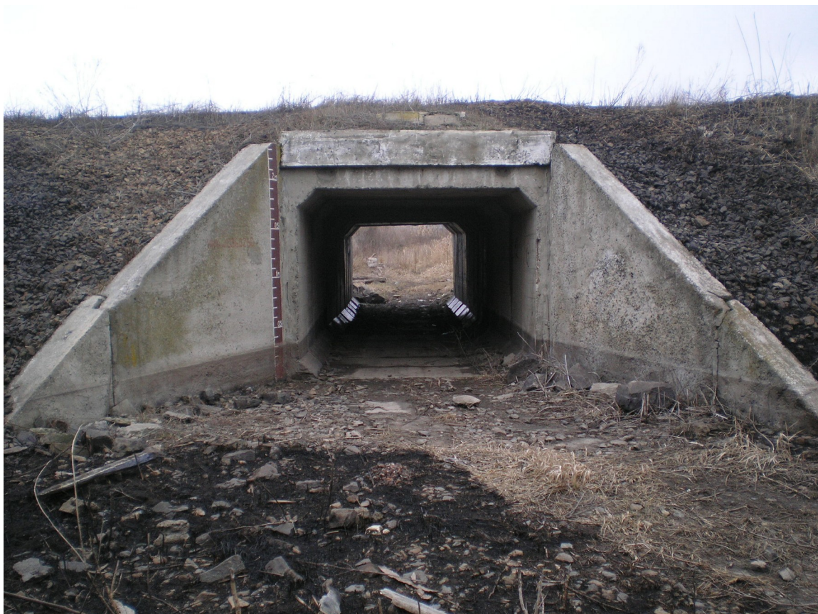
Рис.130. Залізобетонна прямокутна труба
