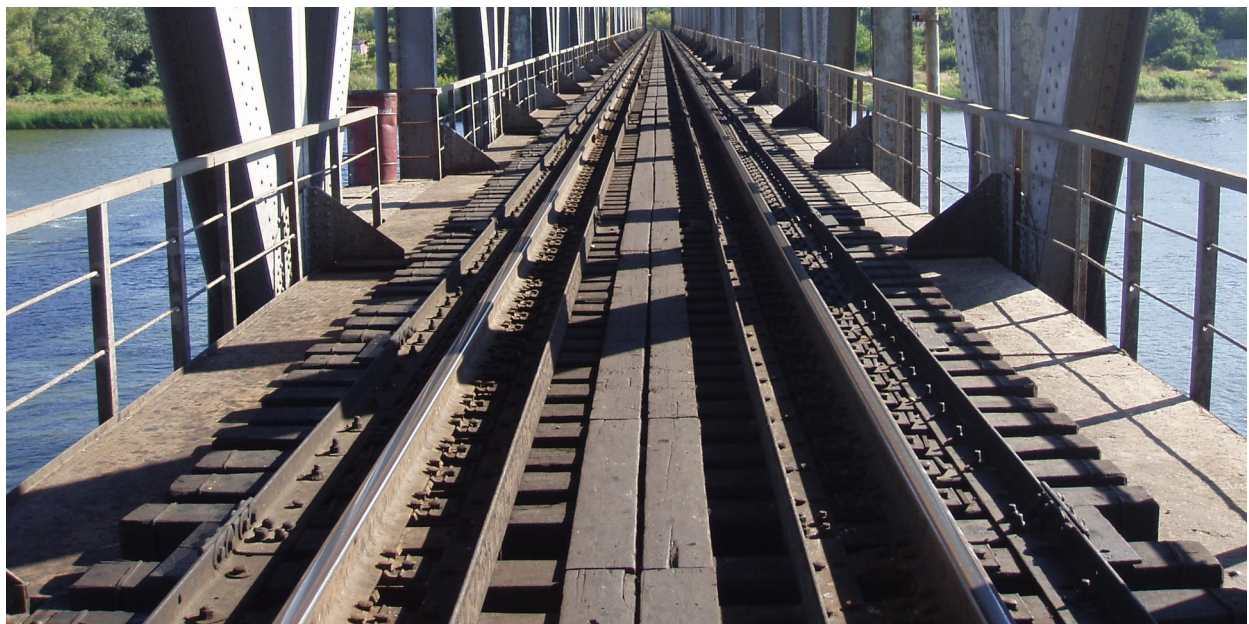
Рис. 104. Експлуатоване мостове полотно з контруктниками
