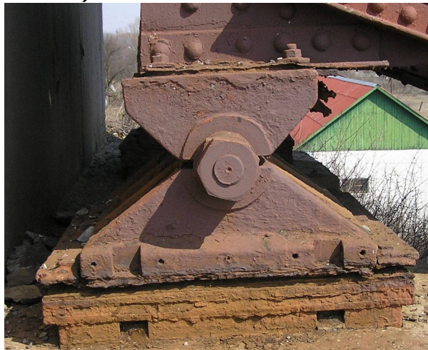
Рис. 85. Опорні частини малих мостів
