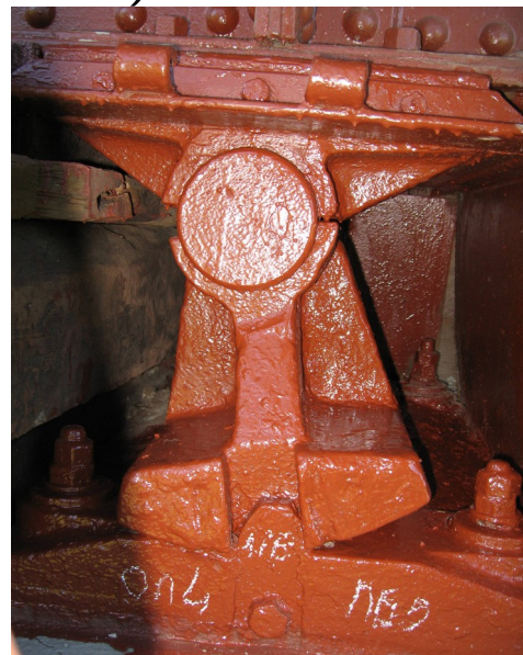
Рис. 87. Багатокоткові і секторні опорні частини
