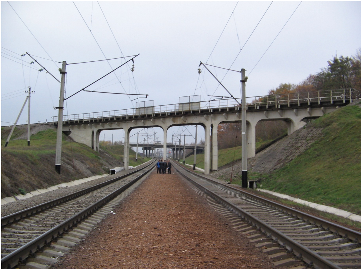
Рис. 35. Рамний залізничний шляхопровід з деформаційними швами
