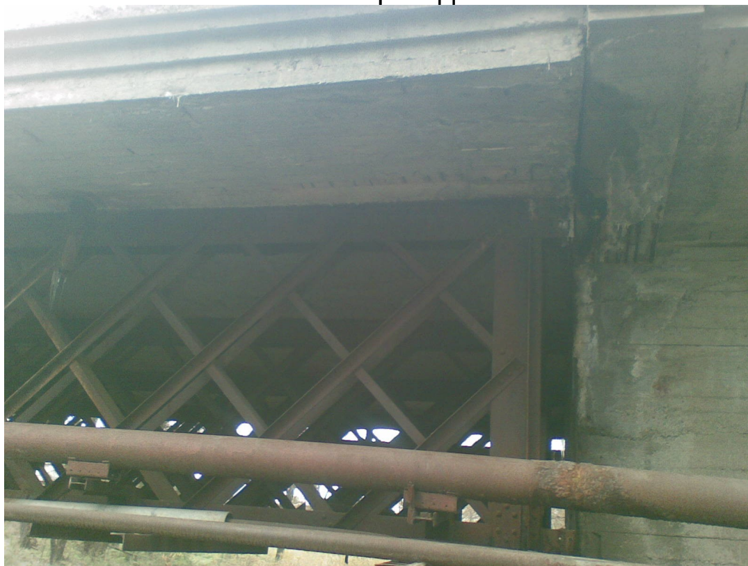
Рис. 52. Сталезалізобетонна прогонова будова
