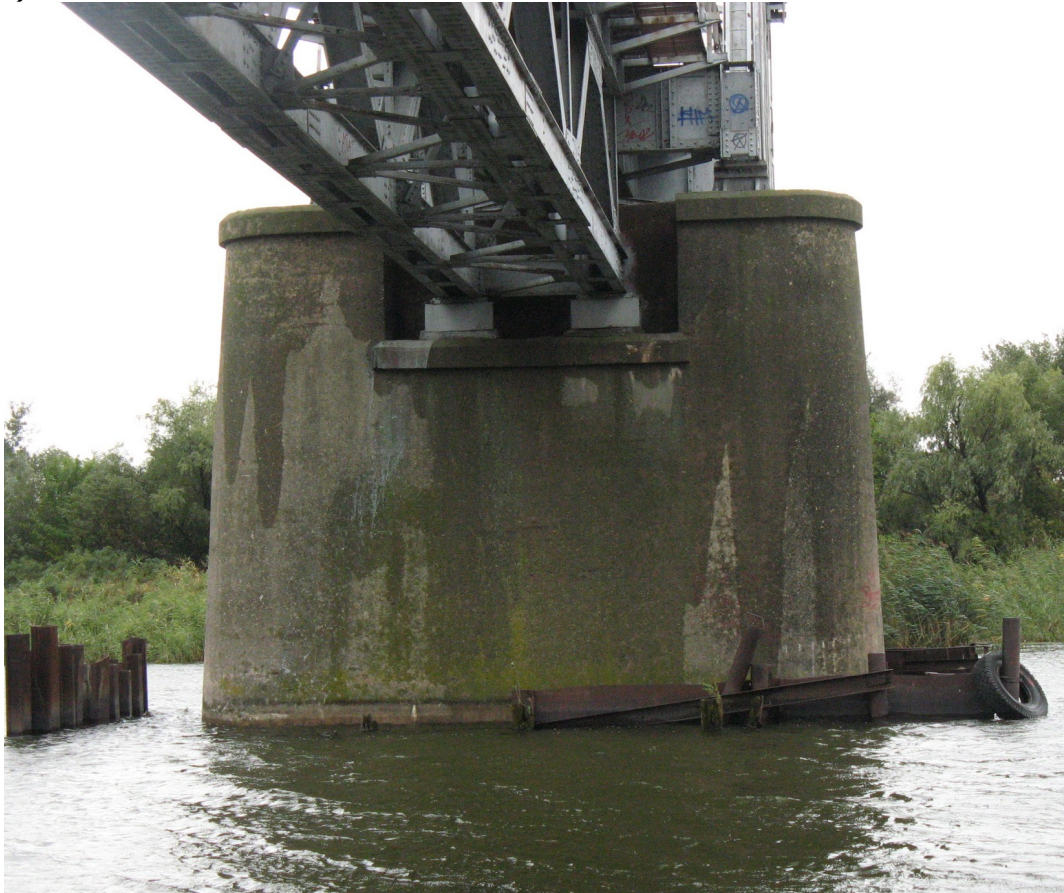
Рис. 80. Конструкції перехідних підфермовиків
