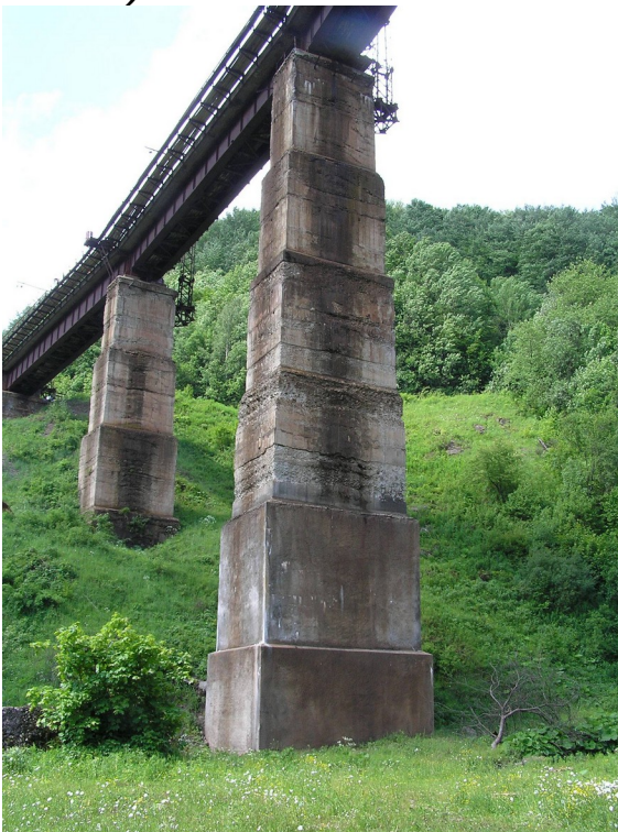
Рис. 78. Конструкції масивних проміжних опор
