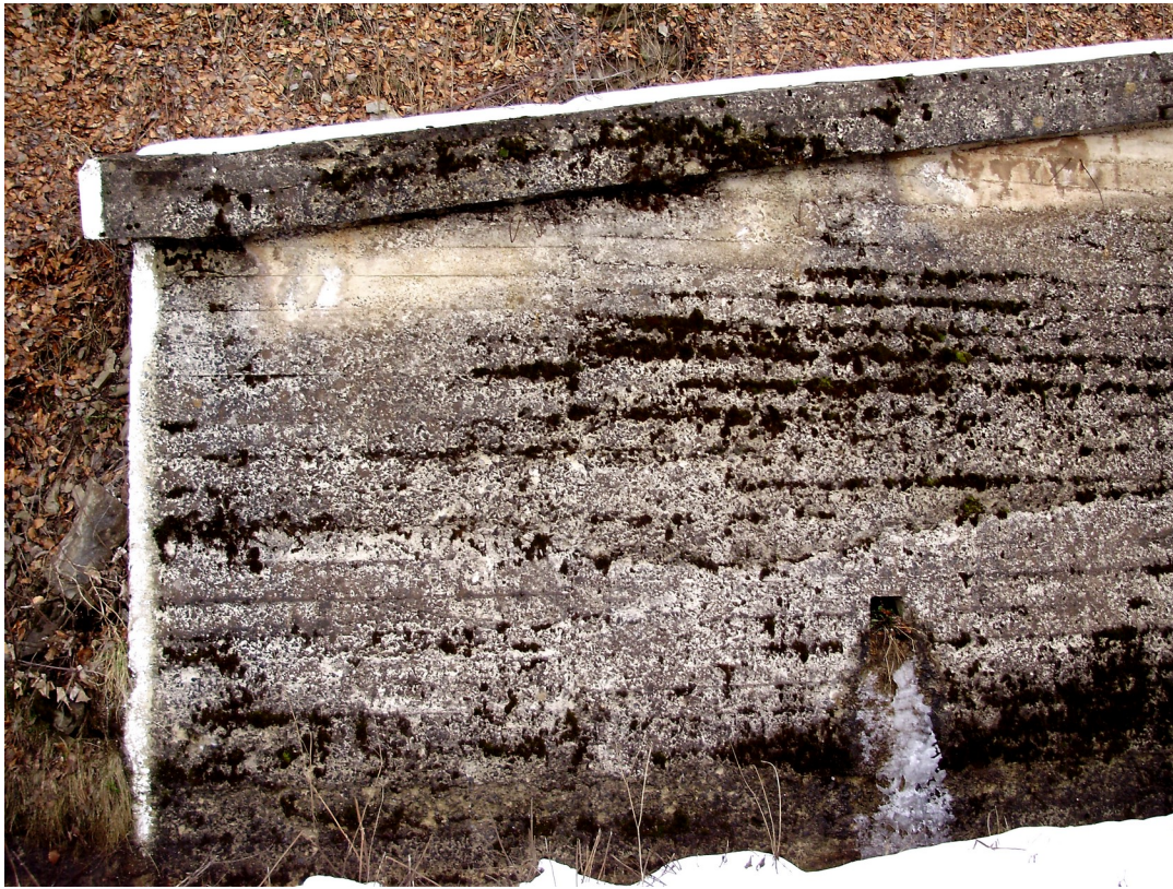
Рис. 145. Дренажний отвір у підпірній стіні
