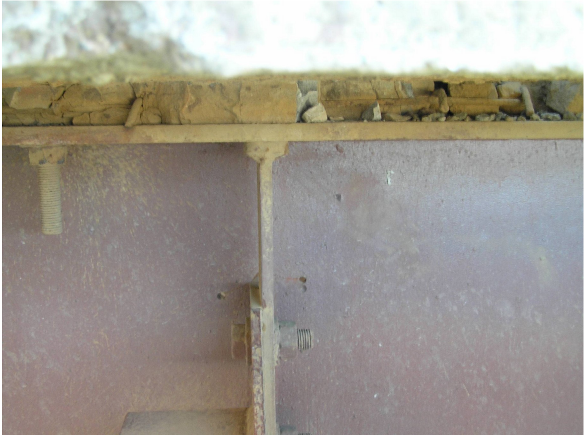
Рис. 111. Прокладний шар з армованого цементно-піщаного розчину
