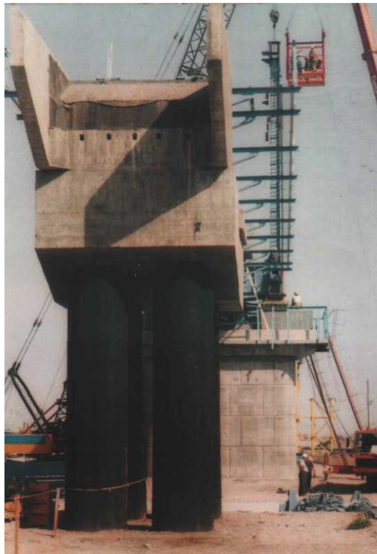
Рис. 82. Монолітний стоян на залізобетонних оболонках
