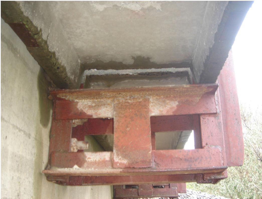
Рис. 29. Улаштування тротуарних плит на приставних консолях
