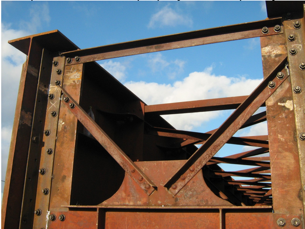
Рис. 49. Прогонова будова з суцільними балками
