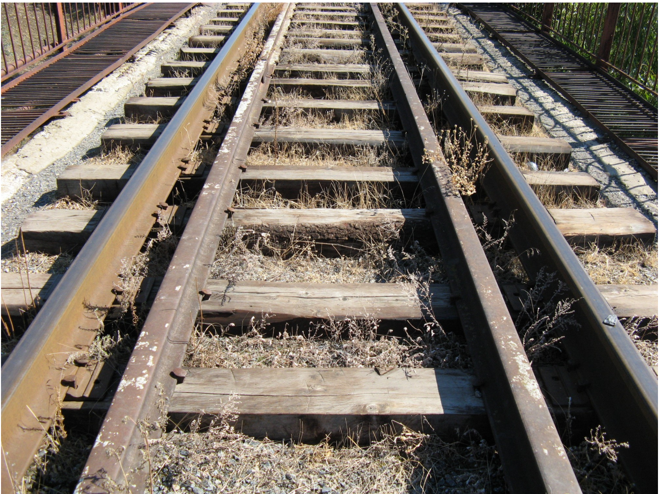
Рис. 96. Експлуатоване мостове полотно на дерев'яних шпалах
