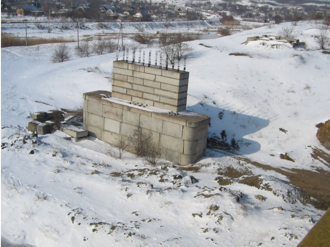
Рис. 79. Конструкція збірної опори
