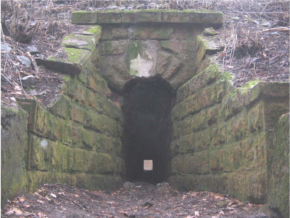
Рис. 124. Кам'яна труба в насипі з розтрубним оголовком
