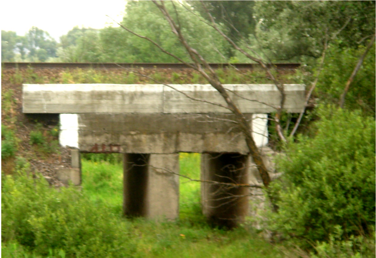
Рис. 127. Збірна двоочкова бетонна труба
