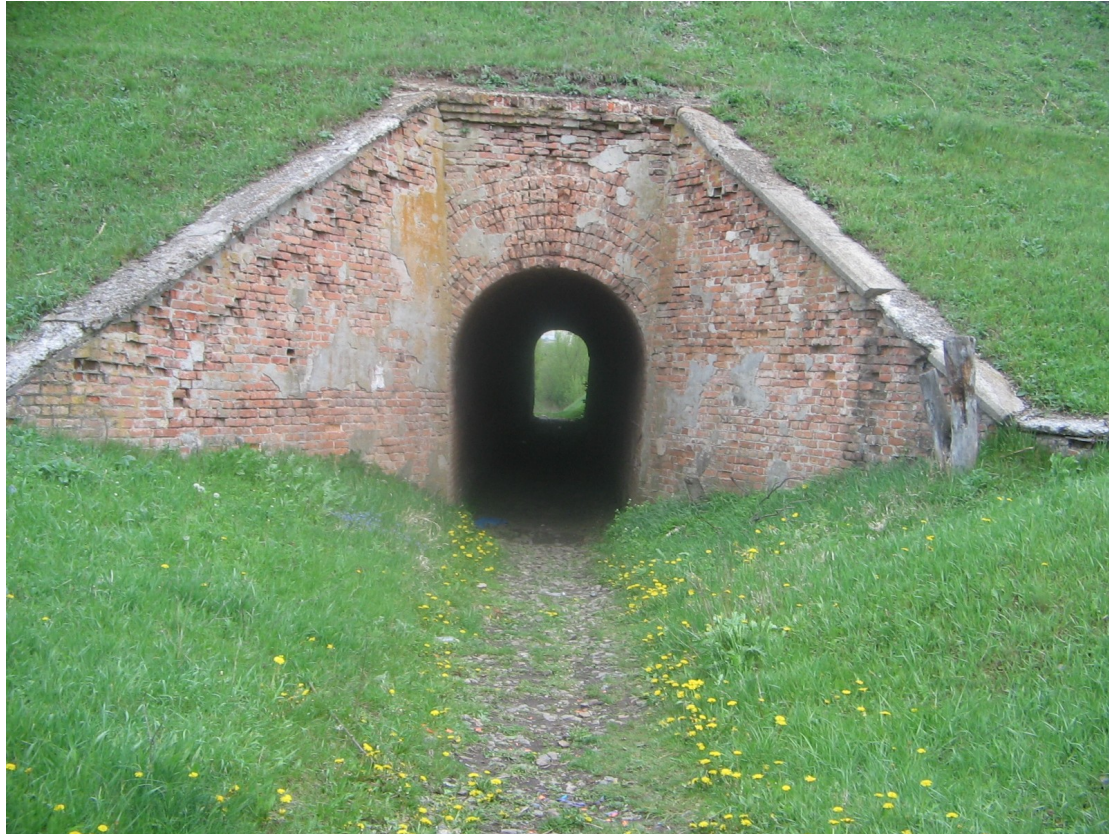
Рис. 120. Цегляна труба з розтрубним оголовком
