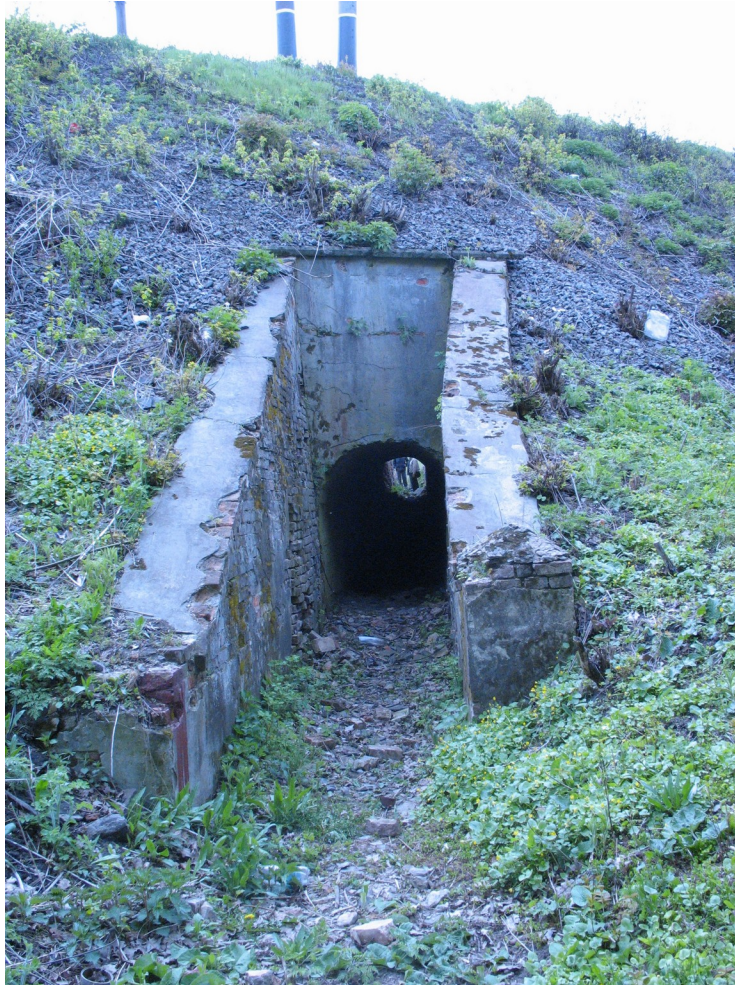
Рис. 121. Скісна цегляна труба
