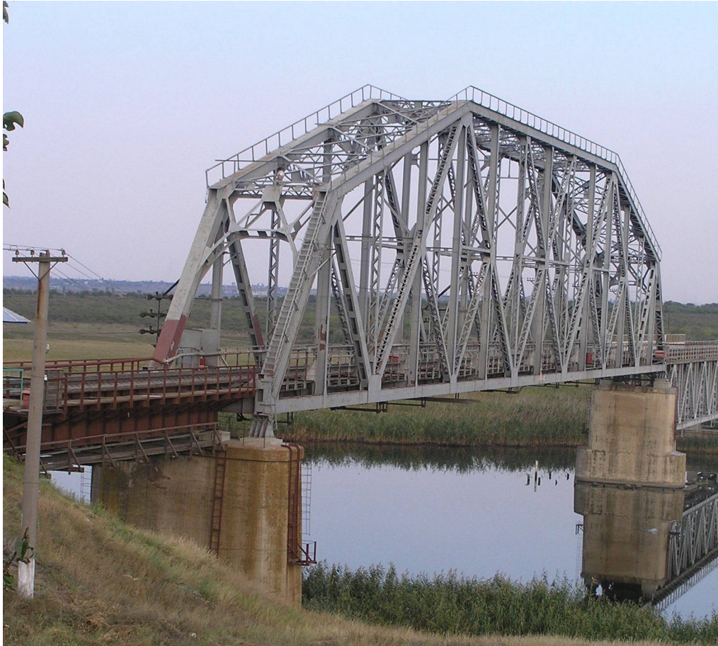
Рис. 61. Металева наскрізна ферма з верхнім полігональним поясом
