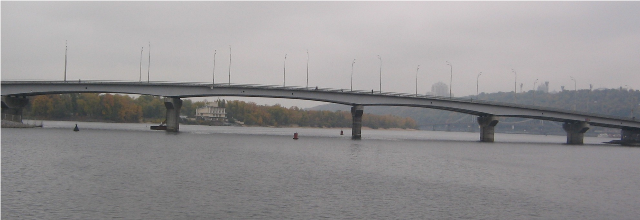
Рис. 68. Нерозрізний металевий міст
