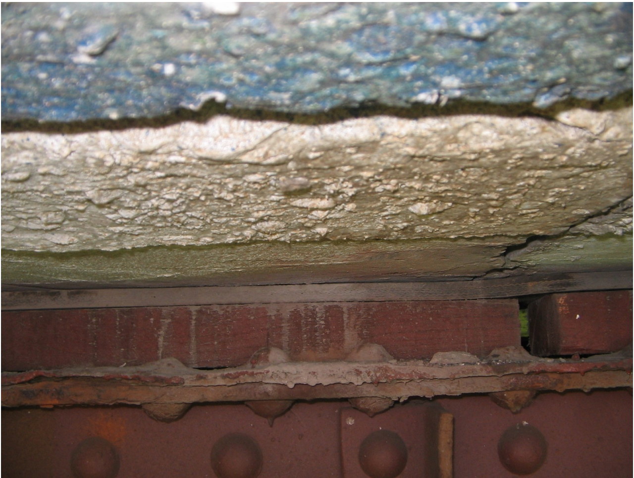
Рис. 110. Прокладний шар з гуми і дерев'яної дошки
