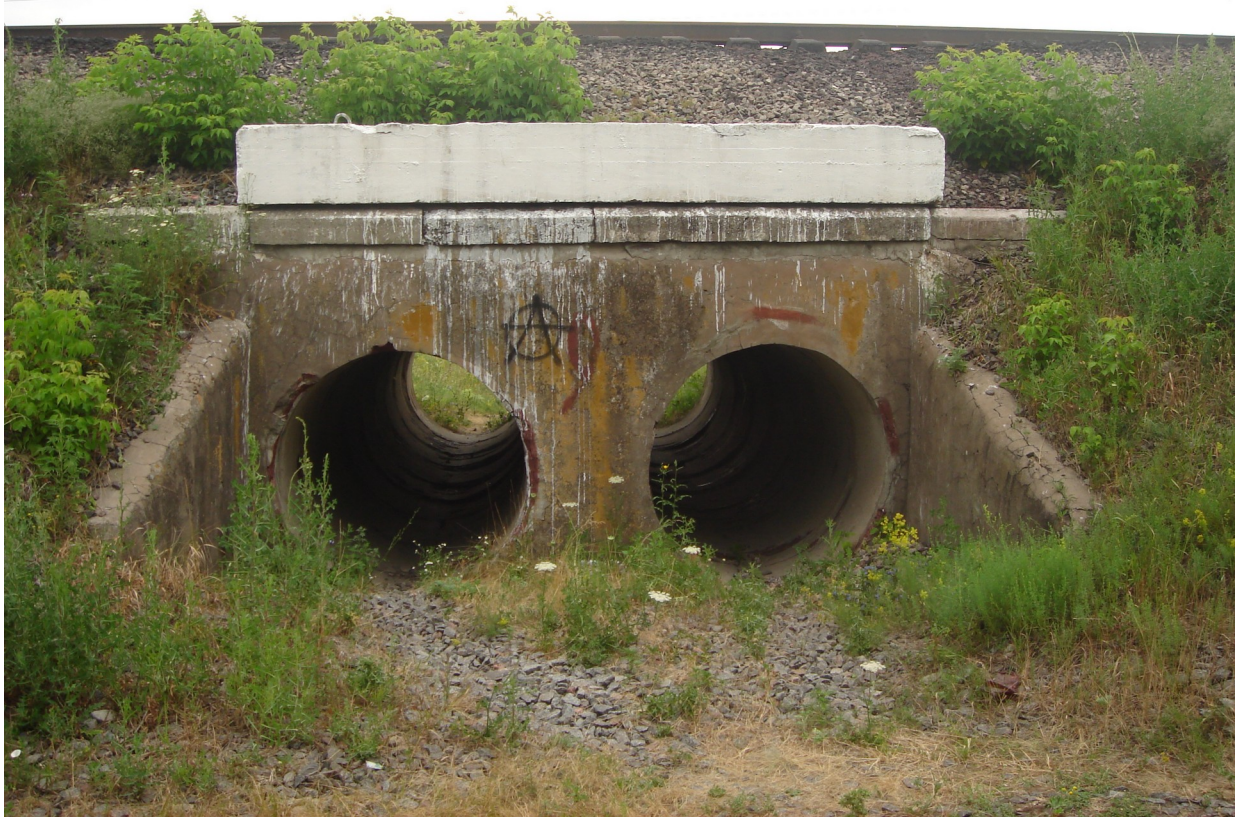
Рис. 129. Кругла двоочкова залізобетонна труба діаметром 1 м
