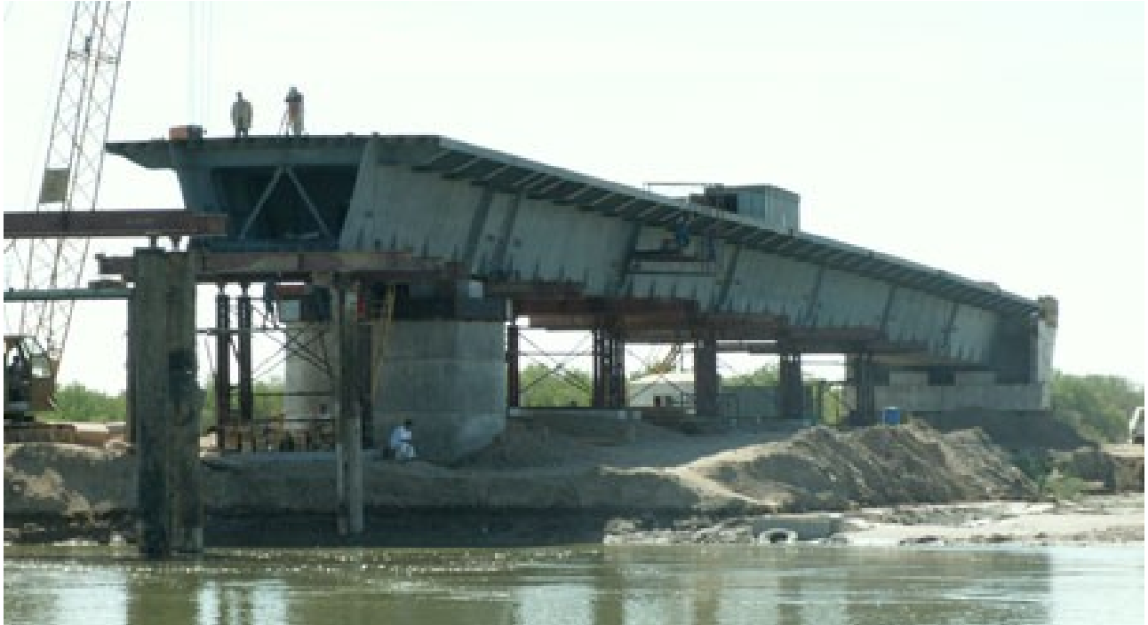
Рис. 65. Нерозрізна прогонова будова коробчастого перерізу
