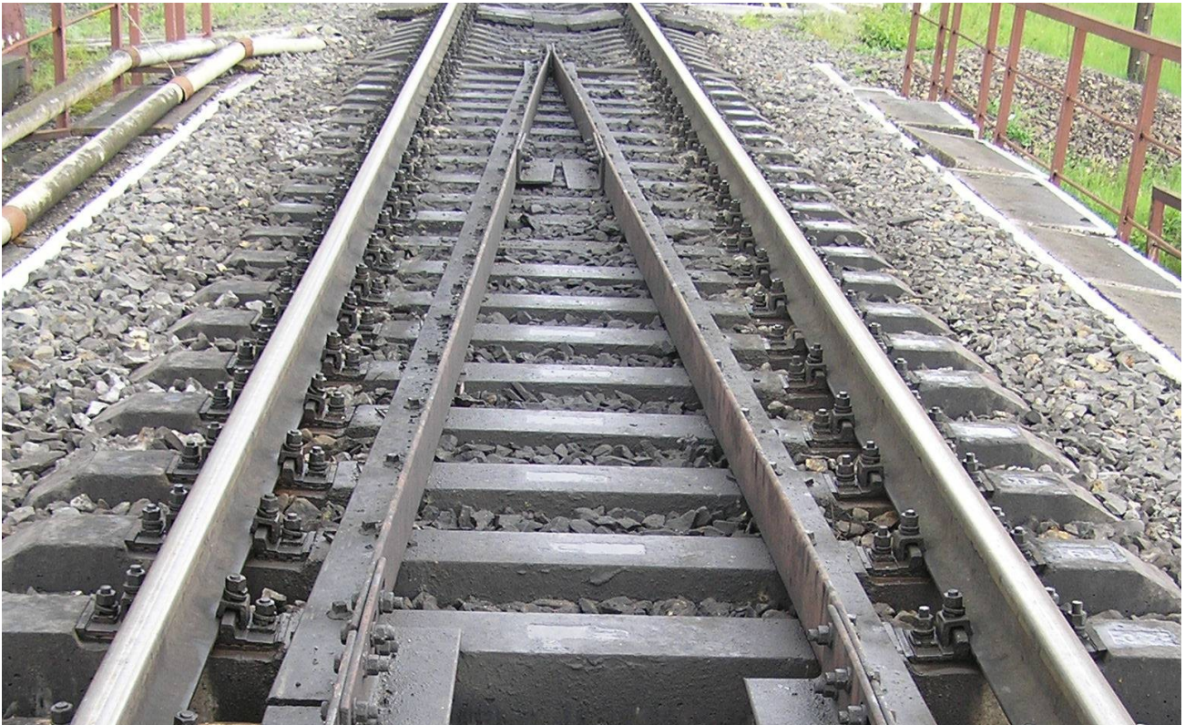
Рис. 98. Розкладка спеціальних залізобетонних шпал за межами моста
