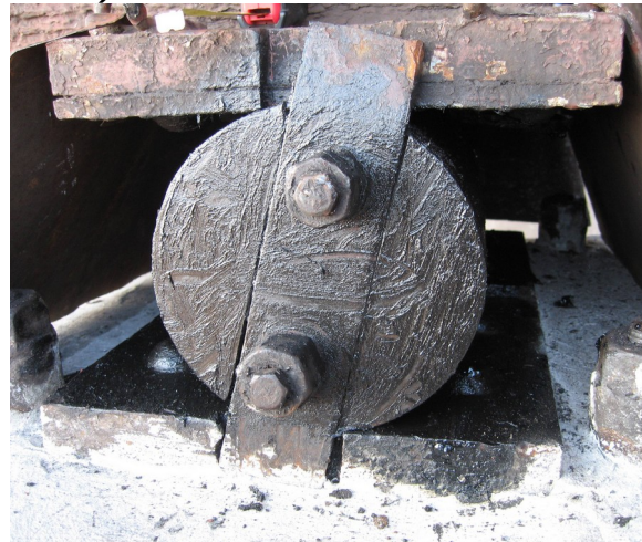
Рис. 85. Опорні частини малих мостів
