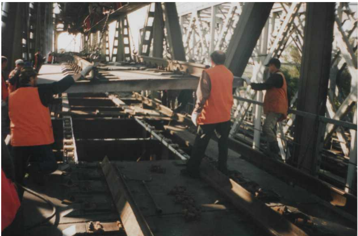
Рис. 1.3. Заміна колії на мосту біля ст. Новоселівка Південної залізниці. Червень 2003 р.
