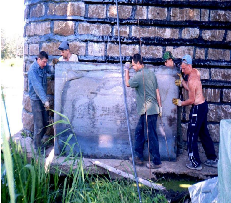
Рис.4.3. Ремонт опори мосту через р.Сіверський Донець біля ст. Будинок відпочинку Південної залізниці. 2003 - 2006 рр.
