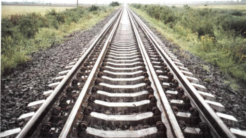
Рис. 2.2. Дослідна ділянка суміщеної рейкової колії 1520 і 1435 мм
