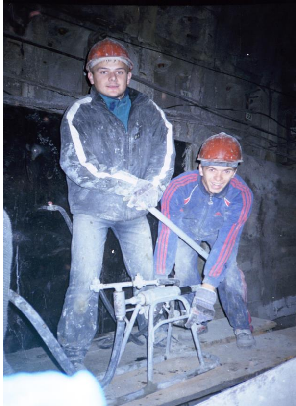
Рис. 3.7. Ремонт тунелю біля ст. Ужок Львівської залізниці. Вересень 2006 г.
