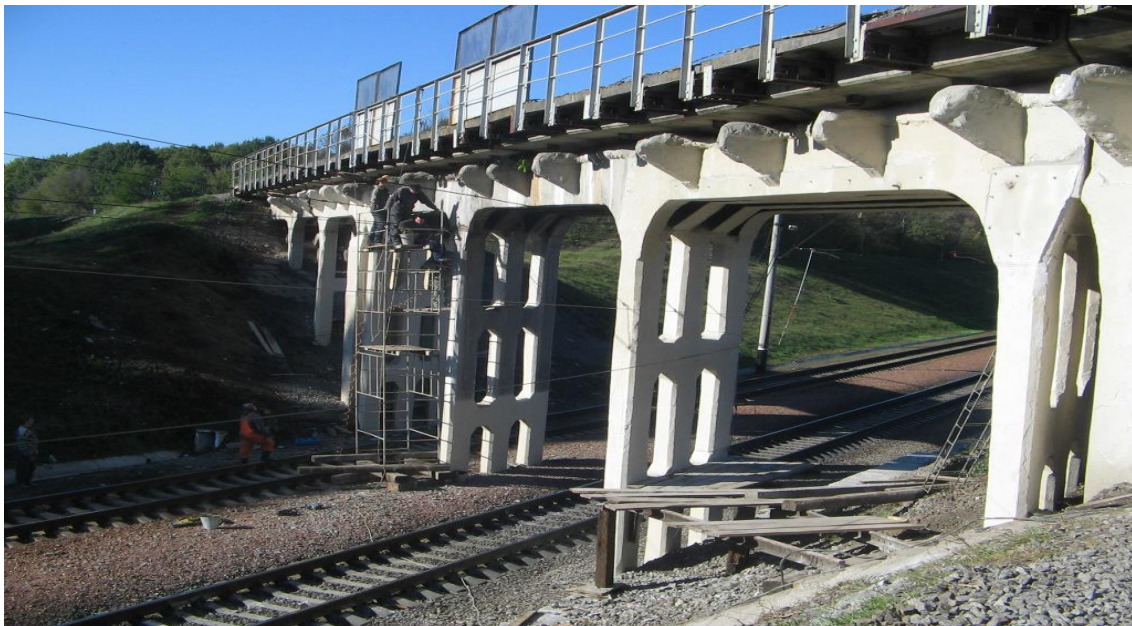
Рис.3.5 Ремонт залізничного шляхопроводу на ст. Гребінка Південко-західної залізниці. Вересень 2006 р.
