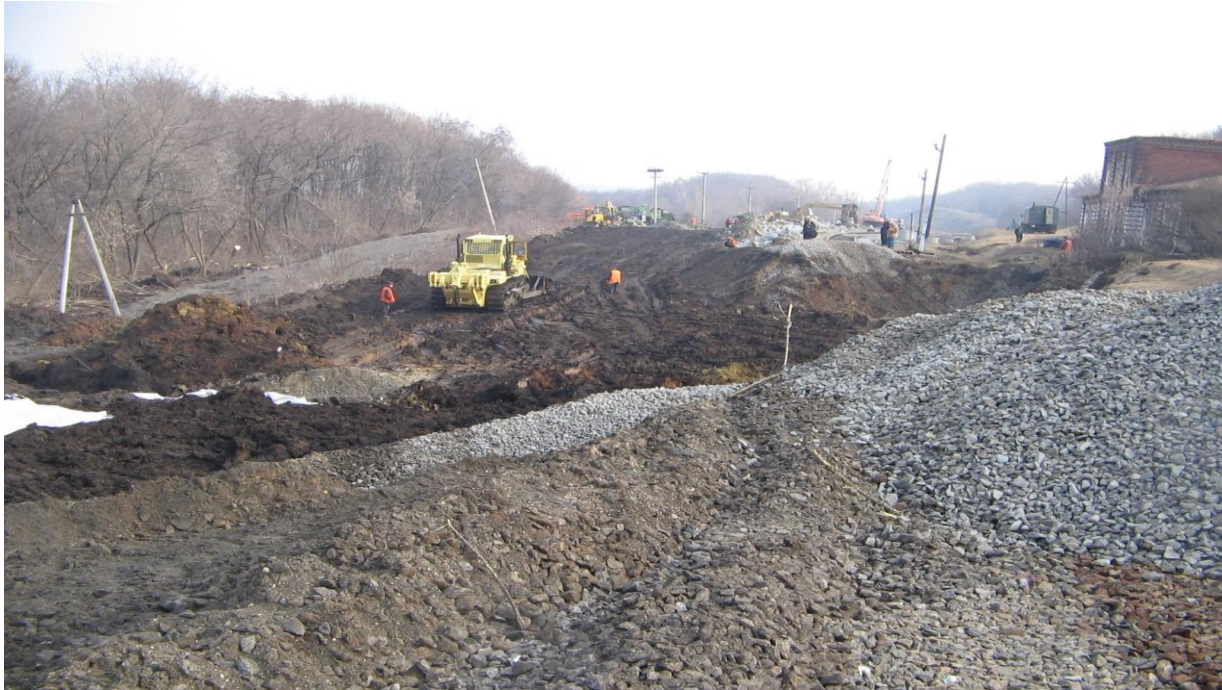
Рис. 1.2. Ремонт насипу біля ст. Кривошиївка Південної залізниці. Квітень 2006 р.
