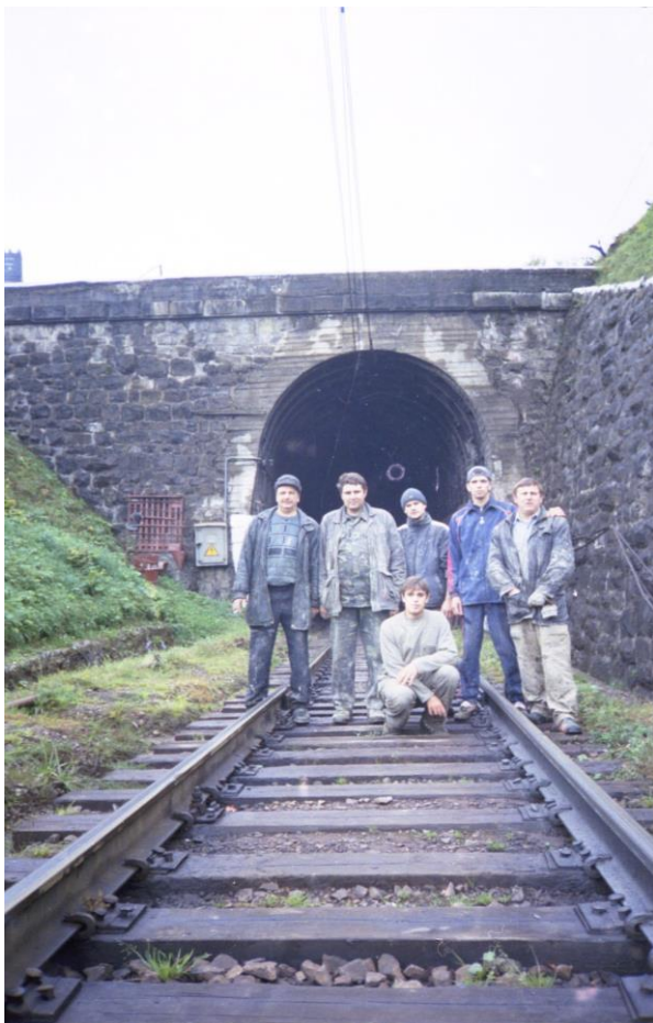
Рис. 3.6. Ремонт тунелю біля ст. Ужок Львівської залізниці. Загальний вид. Вересень 2006 р.
