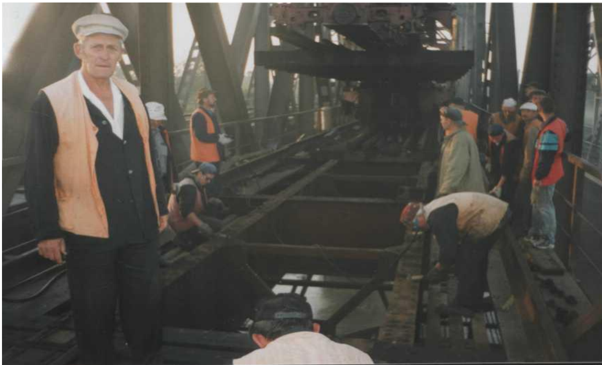
Рис. 4.1. Заміна колії на мосту біля ст. Новоселівка Південної залізниці. Червень 2003 р.
