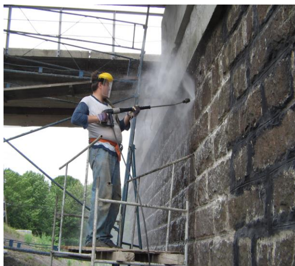
Рис. 4.5. Ремонт опори мосту через р. Сіверський Донець біля ст. Будинок відпочинку Південної залізниці. 2003 - 2006 рр.
