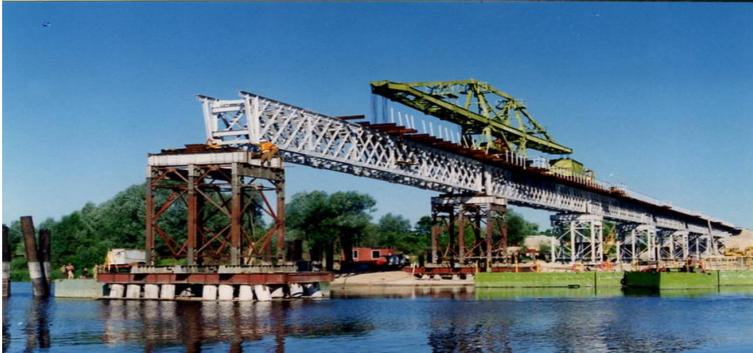
Рис. 2.1. Монтаж залізничного мосту через р. Кубань
