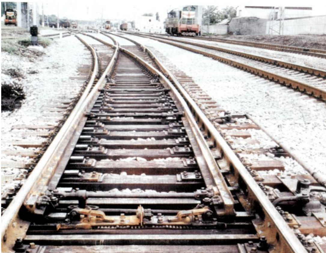
Рис. 3.2. Криволінійний стрілочний перевід типу Р65 марки 1/11
