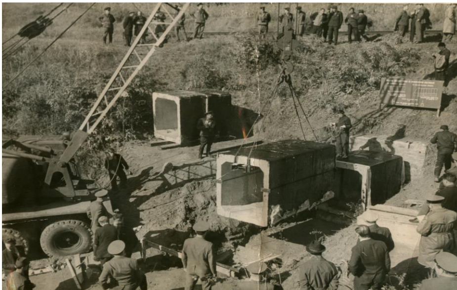
Рис. 1.6 Укладення ланцюгів труби біля залізничного насипу. Україна. Наприкінці 70-х рр.
