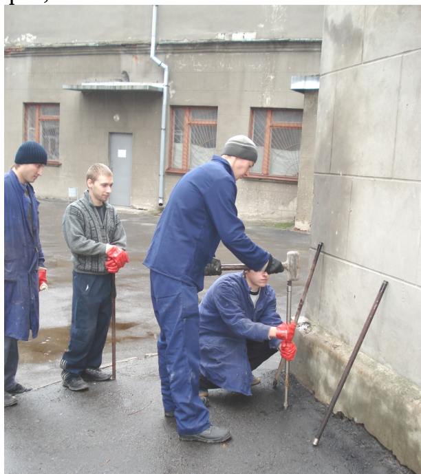
Рис. 3.18 Занурення ін'єктора для нагнітання силікатного розчину
