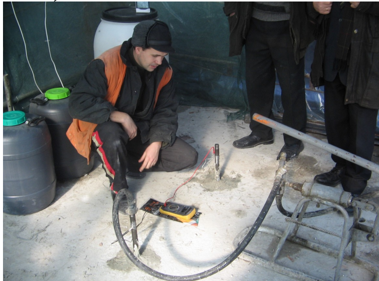
Рис. 3.11. Виробництво робіт із силікатизації ґрунту: а - приготування гелеутворюючого розчину; б - ін'єктори, приготовані для нагнітання силікатного розчину; в - нагнітання силікатного розчину за допомогою ручного поршневого насоса (роботи проводяться в холодну пору в «тепляку»); г - оцінка радіуса закріплення за допомогою електричних вимірювань (змінення електричного опору ґрунту між суміжними ін'єкторами)
