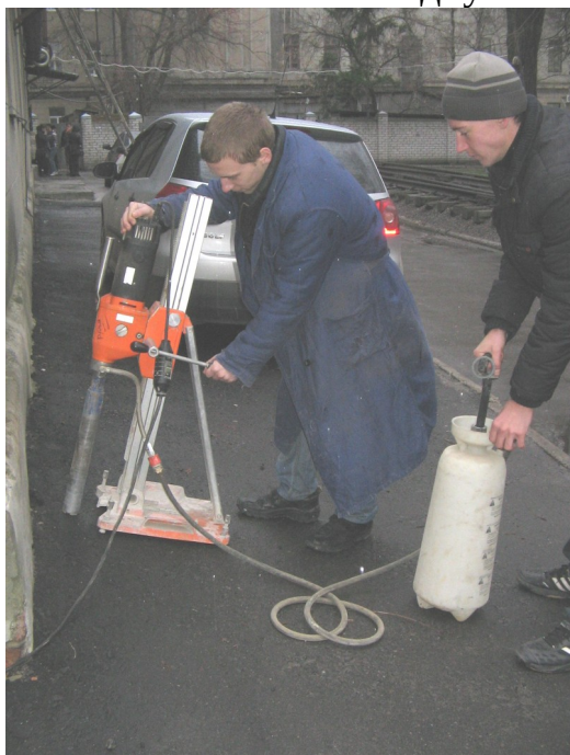
Рис. 3.17. Свердління отворів у вимощенні
