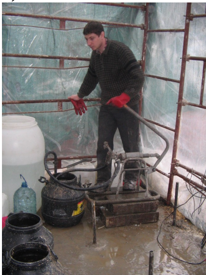
Рис. 3.11. Виробництво робіт із силікатизації ґрунту: а - приготування гелеутворюючого розчину; б - ін'єктори, приготовані для нагнітання силікатного розчину; в - нагнітання силікатного розчину за допомогою ручного поршневого насоса (роботи проводяться в холодну пору в «тепляку»); г - оцінка радіуса закріплення за допомогою електричних вимірювань (змінення електричного опору ґрунту між суміжними ін'єкторами)
