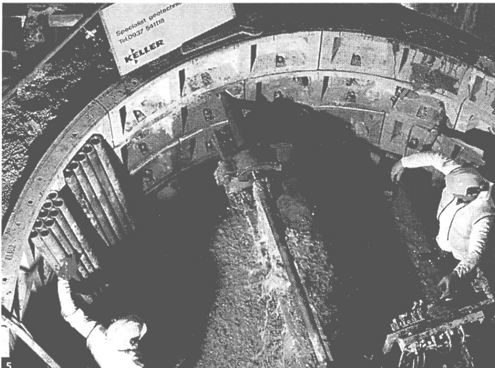
Рис. 3.36. Застосування методу високонапірної ін'єкції при прокладенні транспортного тунелю під житловими будинками у м. Білефельді
