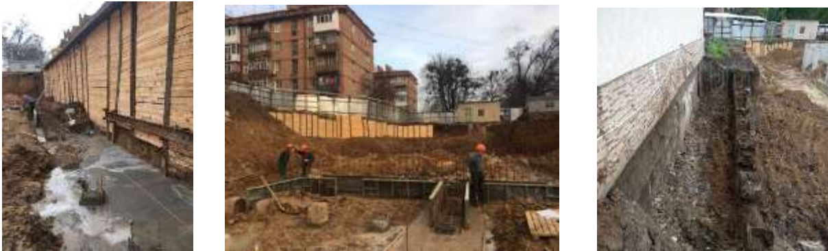
Рис. 4 – Влаштування котловану та елементів його огородження
