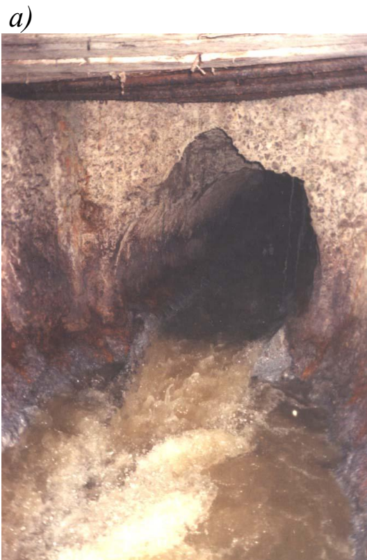
Рис. 5.9. Мікробіологічна корозія залізобетонного каналізаційного колектора: а – вигляд корозійного пошкодження надводних поверхонь з камери оглядового колодязя; б – схема корозії
