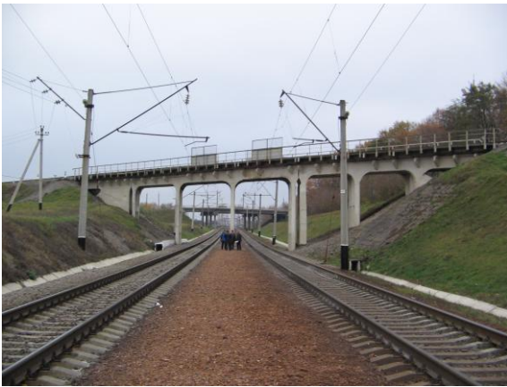
Залізобетонний рамний коліспровід на 802 км ділянці Гребінка – Черкаси Південної залізниці (2006)
