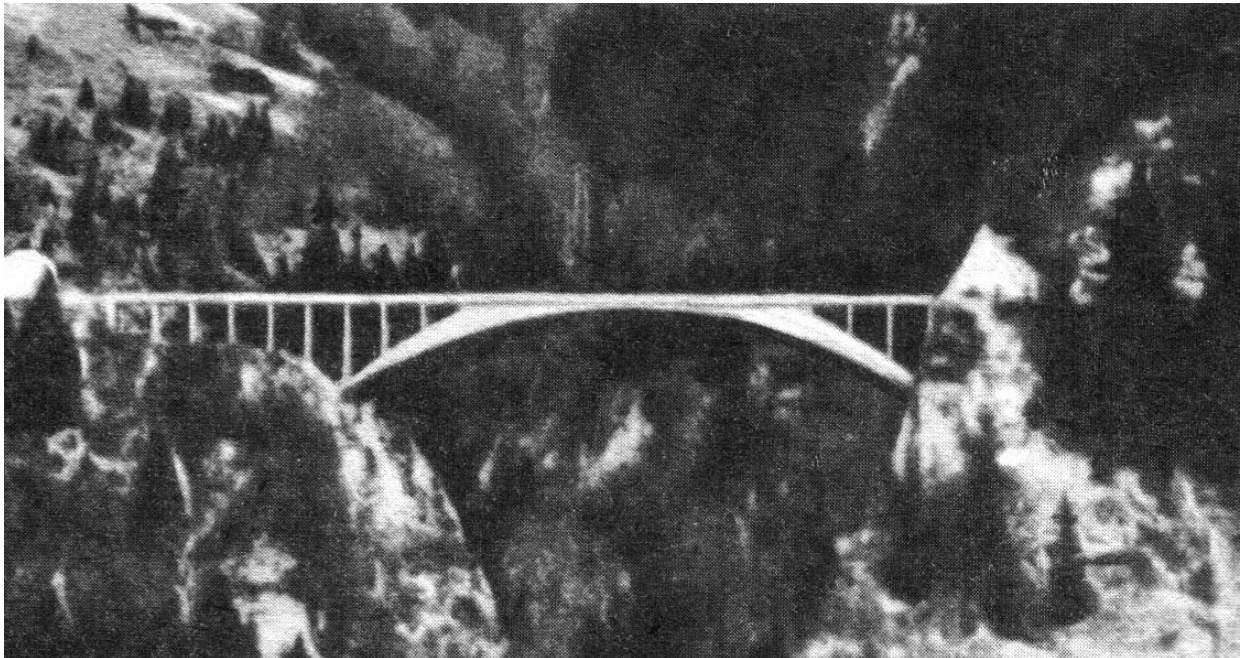
Рис. 2.30. Міст Салгінатобеле через ущелину Сальгіна, Швейцарія Залізобетонний арковий з їздою поверху, довжиною прогону 90 м. Збудований у 1929÷30 рр. за проектом Робера Майара (Maillart)
