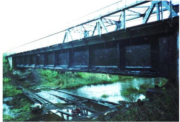
Залізобетонна прогонова споруда мосту на 68 км ділянці Ворожба – Люботин Південної залізниці (2003÷04)
