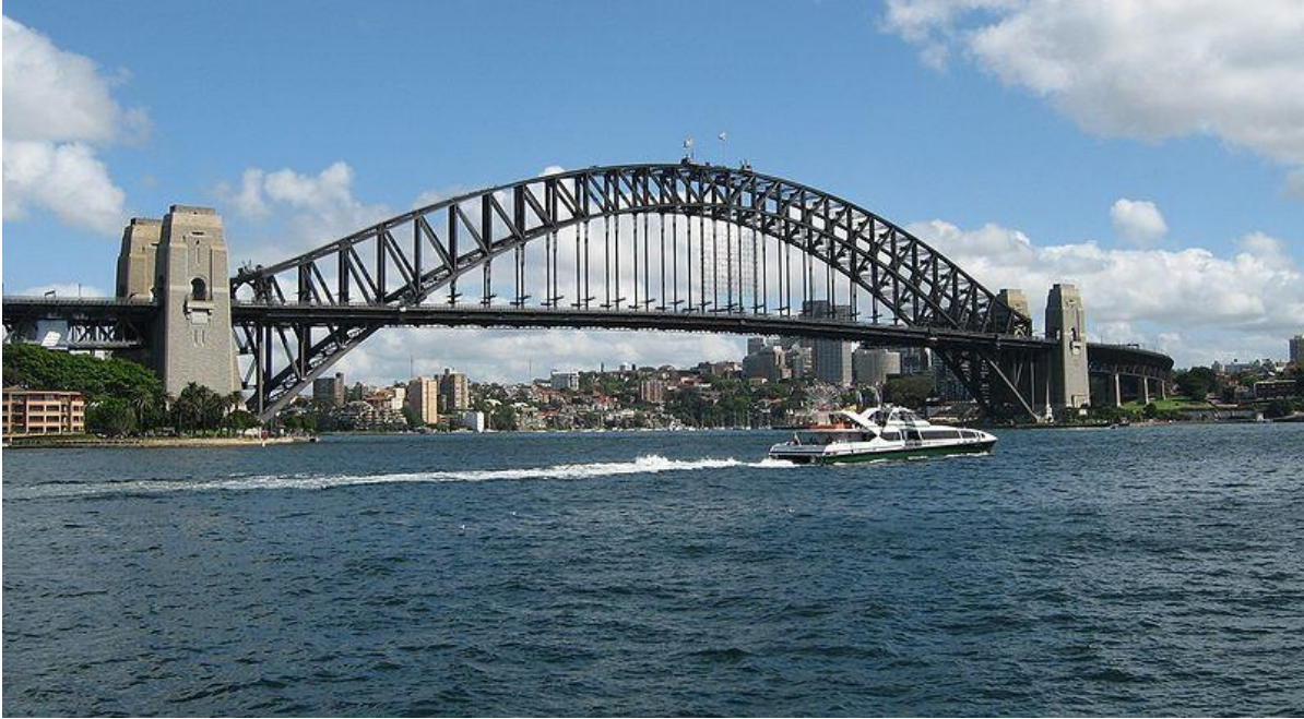
Рис. 2.29. Міст Sydney Harbour Bridge через затоку Порт-Джексон, м. Сідней, Австралія Сталевий арковий з їздою посередині, довжина прогону 503 м. Збудований у 1931 р.
