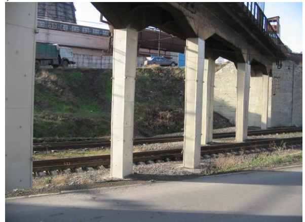
Залізобетонний рамний коліспровід №26 АТ «ММК «Азовсталь» (2007, підрядник ТОВ «Трансстрой»)
