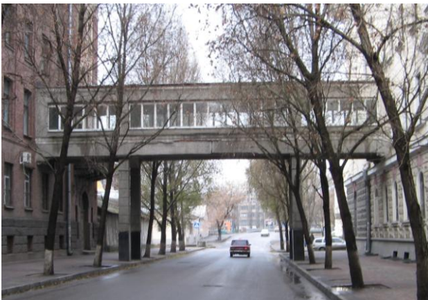
Залізобетонні стояки переходу між корпусом №1 і корпусом №2 УкрДАЗТ (2006)
