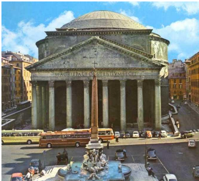
Рис. 2.9. Пантеон, Рим, Італія Діаметр купола – 43,2 м; монолітний бетон на вапні з пуцоланою, цегляний каркас, облицювання мармуром; побудований бл.125 р.; архітектор – імовірно Аполодор Дамаський
