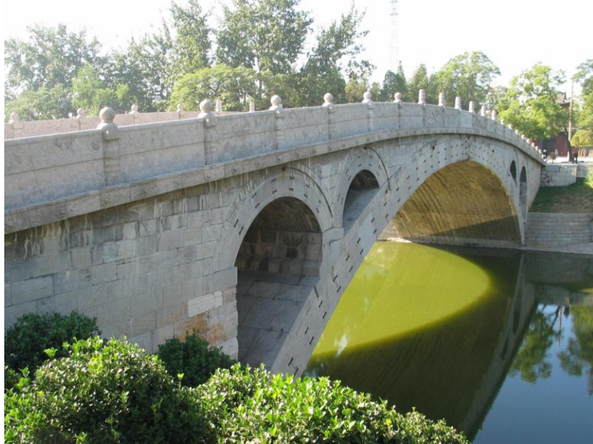
Рис. 2.24. Міст Чжаочжоу, пров. Хебей, Китай Кам'яний арковий; довжина прогону 37,37 м, повна довжина мосту 50,82 м, висота 7,3 м. Збудований у 595÷605 рр.
