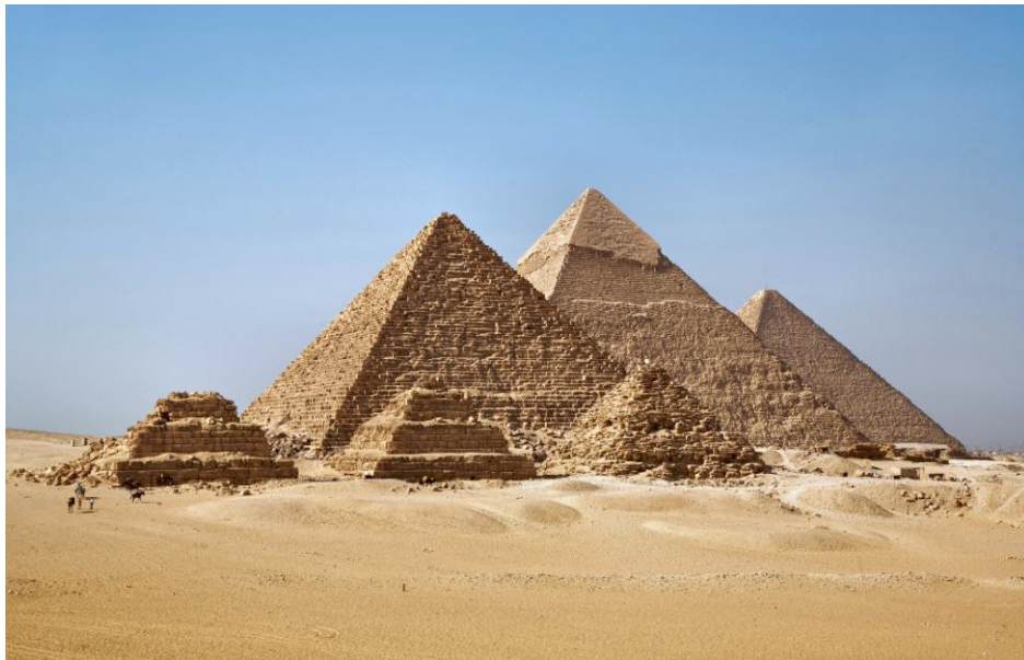
Рис. 2.5. Великі піраміди, м. Гіза, Єгипет: Хеопса, Хефрена (143,5 м), Мікеріна (65,5 м). Найбільша – піраміда Хеопса: висота – 146,6 м (зберіглось 138,8 м), розміри – 230×230 м, площа забудови – 53 тис. м 2 , вага – 6,4 млн т; кладка із вапнякових блоків вагою 2÷14 т без розчину (гіпотези: кладка на вапняному молоці або із монолітного вапняного бетону); побудована у 2590÷2568 рр. до н. е.; архітектор – Хеміун; тривалість будівництва – 23 роки, кількість робітників-будівельників – до 20÷100 тис.; вартість будівництва – 1600 талантів (бл. 25÷30 млн дол. США). Понад 3,5 тис. р. була найвищою будовою у світі
