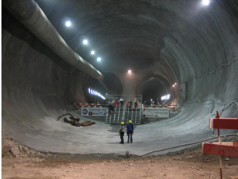
Рис. 2.38. Готардський базовий тунель крізь Швейцарські Альпи, що будується на залізничній лінії Цюрих (Швейцарія) – Мілан (Італія). Залізничний, двоколіїний, довжина – 57 км; терміни будівництва: початок – 1993 р., заплановане уведення в експлуатацію – 2016-17 рр.; кошторисна вартість – 6,248 млрд дол. США
