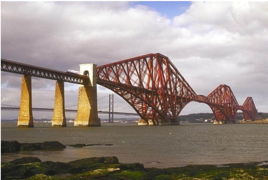
Рис. 2.28. Залізничний міст Фьорс-оф-Форс через затоку Фьорс-оф-Форс поряд з м. Единбург, Шотландія Сталевий двоконсольний зі вставками, аркового окреслення, надводні прогони 2 \times 521 м. Збудований у 1883÷89 рр. за проектом Б. Бекера
