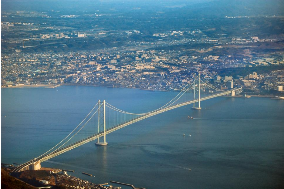
Рис. 2.35. Міст Акасі Кайкьо через протоку Акасі, м. Кобе, Японія Висячий, кабельний. Довжина 3911 м – 960+1991+960 м, висота пілонів – 298 м. Збудований у 1988÷98 рр. Кошторисна вартість – бл. 5 млрд дол. США
