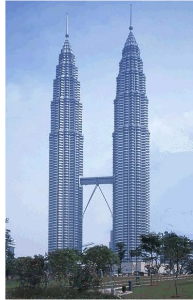
Рис. 2.19 Вежі-близнюки Петронас, Куала-Лумпур, Малайзія Висота – 451,9 м; кількість поверхів – 88; попередньо напружений залізобетон; збудовані у 1992÷97 рр.; кошторисна вартість – 800 млн. дол. США
