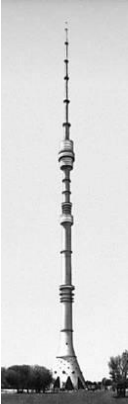
Рис. 2.16. Останкінська телевежа, Москва, Росія Висота – 540 м, діаметр в основі – 63 м, вага – 51,4 тис. т; попередньо напружений залізобетон; збудована у 1963÷67 рр., тривалість будівництва – 54 місяці; конструктор – М.В. Нікітін
