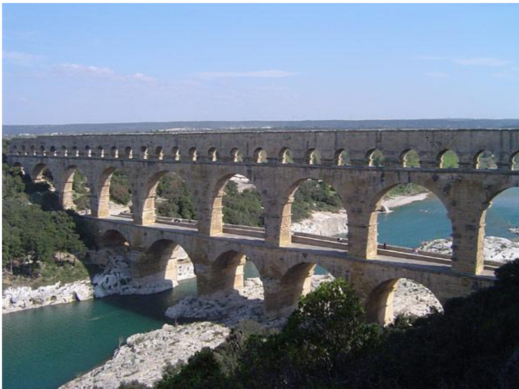
Рис. 2.23. Акведук Пон-дю-Гар (Нім, Франція) Довжина – 275 м (всього водопроводу – 50 км), висота – 47 м; потужність – 20 тис. м 3 води на добу. Збудований у 19 р. до н. е.
