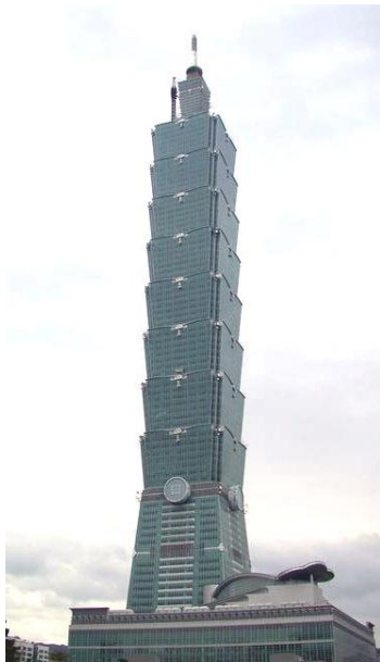
Рис. 2.20. Тайбей 101; Тайбей, Тайвань Висота – 509,2 м; поверхів – 101; сталеві конструкції; збудований у 1999÷2003 рр; архітектори – С.У. Lee & Partners; кошторисна вартість – 1,7 млрд дол.США
