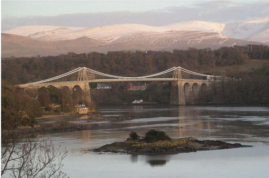
Рис. 2.31. Міст Menai Suspension Bridge через протоку Менай, Північний Уельс Висячий ланцюговий прогоном 176 м. Збудований у 1826 р. Томасом Телфордом
