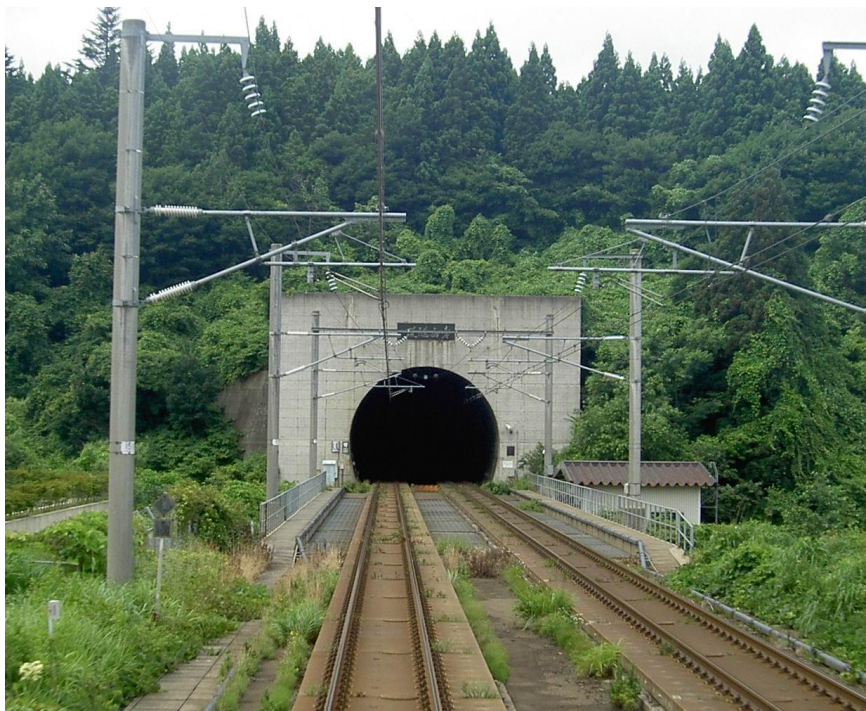
Рис. 2.36. Підводний тунель Сейкан під протокою Цугару між о-вами Хонсю і Хокайдо, Японія Довжина – 53,85 км, підводної частини – 23,3 км; уведений в експлуатацію 03.03.1988; тривалість будівництва – 14 років
