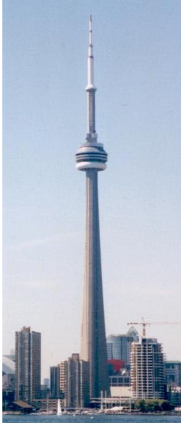
Рис. 2.17. Телевежа CN Tower, Торонто, Канада Висота – 553,33 м; вага – 130 тис.т; попередньо напружений залізобетон; збудована у 1973÷75 рр.; у 1991÷2007 рр. – найвища споруда світу
