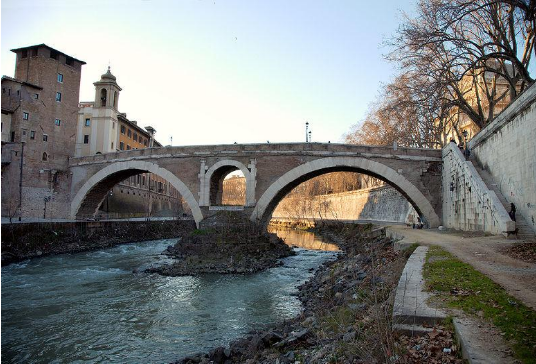
Рис. 2.22. Міст Понте Фабричіо через рукав р.Тибр, Рим Кам'яний арковий, двопрогоновий, з прогоном 24,5 м, повною довжиною 62 м. Збудований у 62 р.до н. е. Луцієм Фабрицієм
