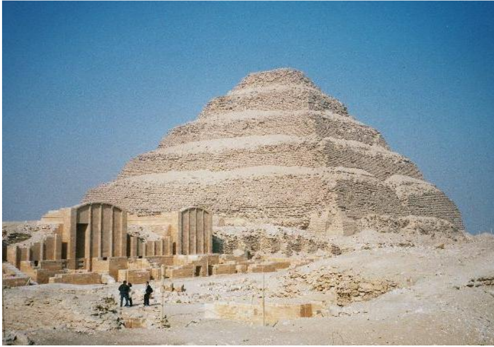
Рис. 2.4. Піраміда Джосера, м. Саккара, Єгипет Висота – 62 м, розміри в плані – 125×115 м; кладка із тесаного каменю на глиняному розчині; побудована бл. 2670 р. до н. е.; архітектор – Імхотеп
