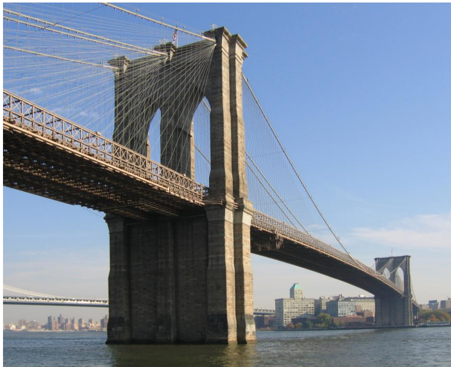
Рис. 2.32. Міст Brooklyn Bridge через р.Іст-Ривер, Нью-Йорк Висячий кабельний 287+486,3+287 м. Збудований у 1870÷83 рр. за проектом Джона Августа Реблінга. Кошторисна вартість 15,1 млн дол. США
