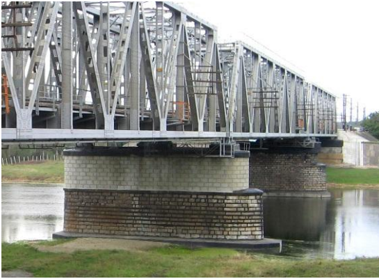
Кам'яні опори мосту на 286 км ділянці Основа – Букине Південної залізниці (2000÷06)
