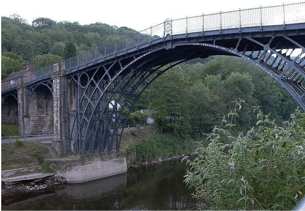
Рис. 2.27. Міст Колбрук Дейл через р. Северн, Англія Чавунний арковий прогоном 30 м. Збудований у 1779 р.. Перший металевий міст. Всього у світі збудовано 47 чавунних мостів
