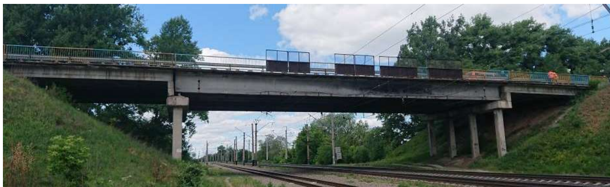
Рис. 1. Загальний вид шляхопроводу зі сторони Харкова
