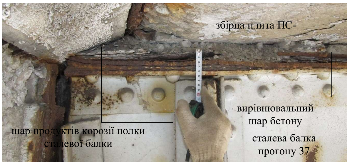
Рис.1. Стан опор низових збірних плит по вісі 36
