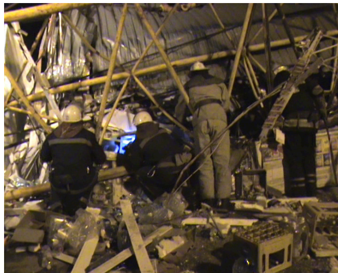
Рис. 1.3. Аварія баштового крану (м. Харків 17.05.14)
