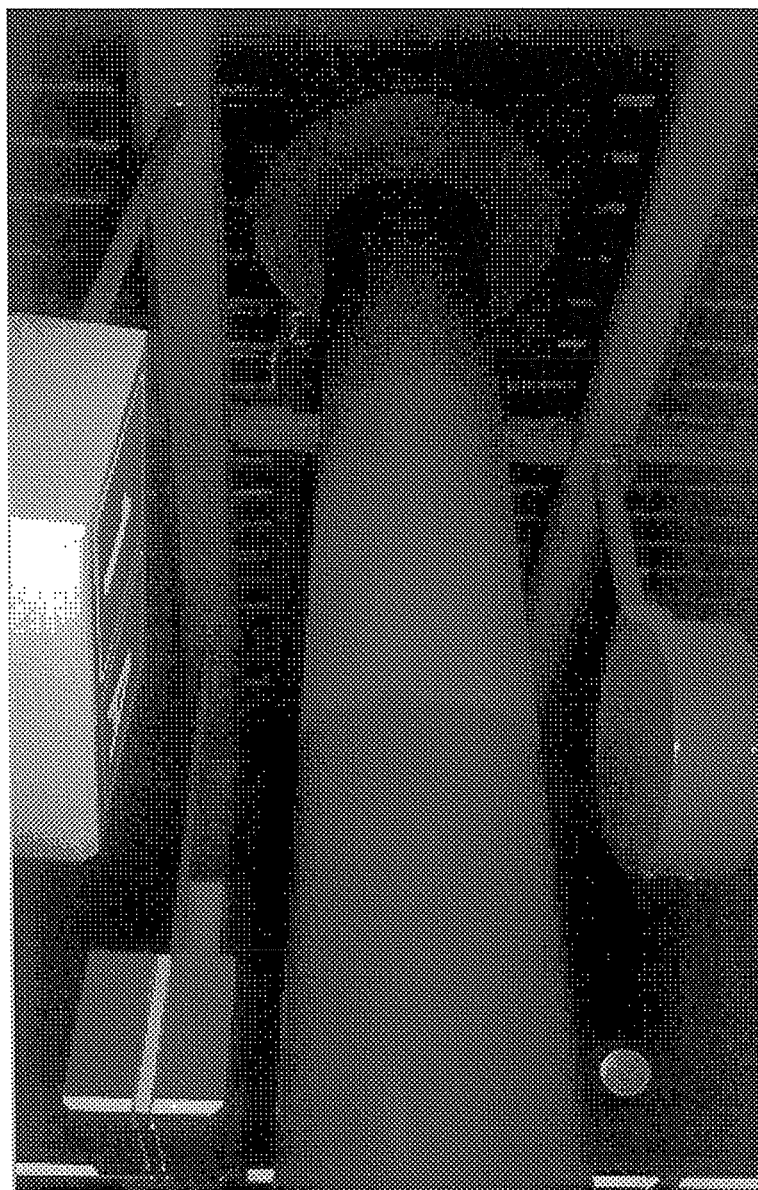
Рис. 4.1 - Узел сопряжения колонн с плитами перекрытия
