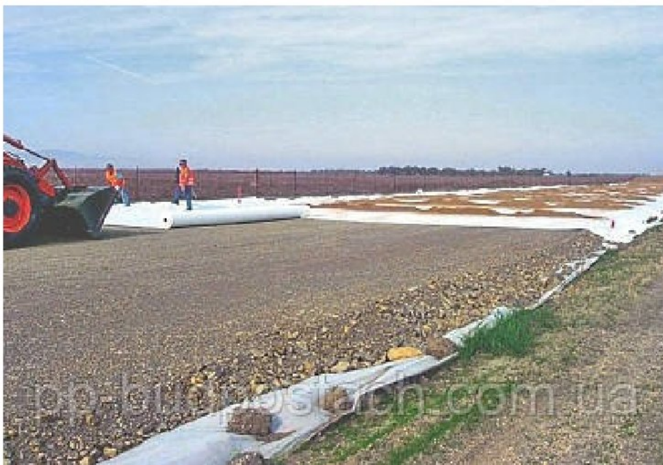
Рисунок 2.2 – Засипання геотекстилю конструктивним шаром
