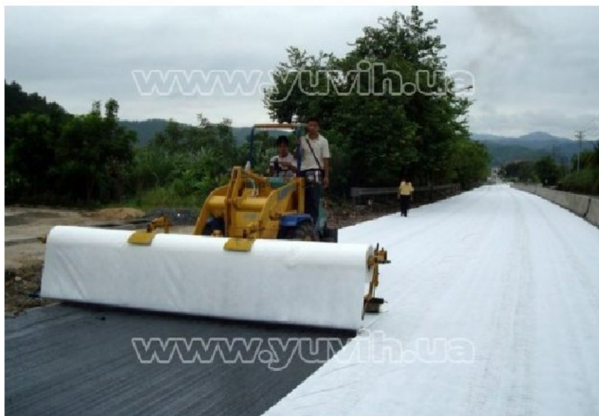
Рисунок 2.1 – Укладання геотекстилю
