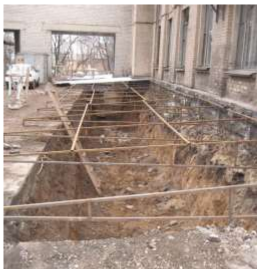
Рис. 3. Загальний вигляд траншеї уздовж стіни будинку
