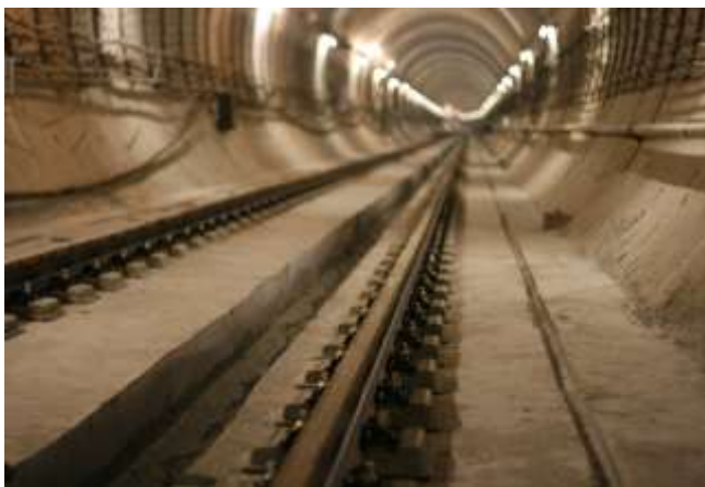
Рис. 7. Експериментальна ділянка на ізолюваних блочних опорах EBS виробництва фірми Tines (Польща) на 1-й колії Куренівсько-Красноармійської лінії Київського метрополітену
