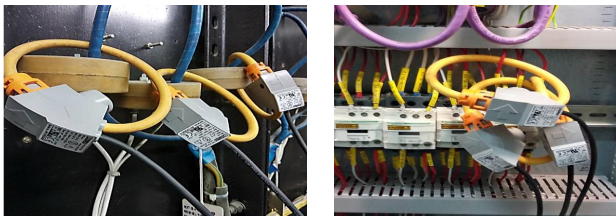
Рисунок 1.3 – Підключення трансформаторів струму
