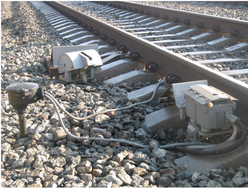
Рисунок 10.8 — Перегінне обладнання системи АСДК-Б
