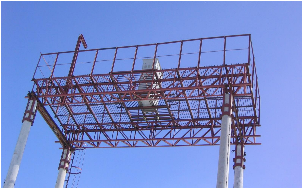
Рисунок 11.4 – Загальний вигляд розміщення блока лазерних випромінювачів на ригельній поперечній балці
