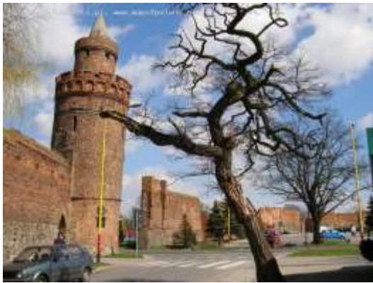
Рис. 19. Совиная башня крепостных стен, г. Пиржице, Польша
