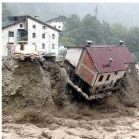
Рис. 6. Отвесный оползень под домом [6]
