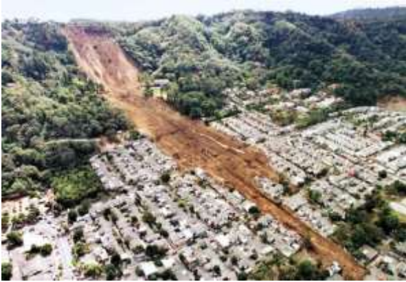
Рис. 8. Далеко растекающийся оползень [8]
