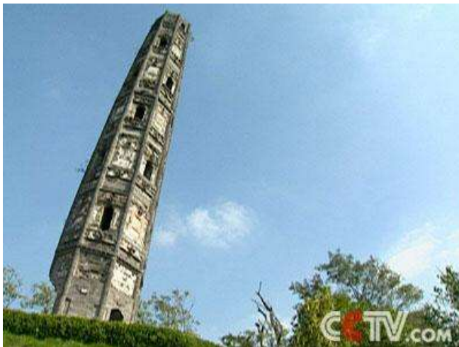
Рис. 21. Падающая башня «Хучжу» в Шанхае
